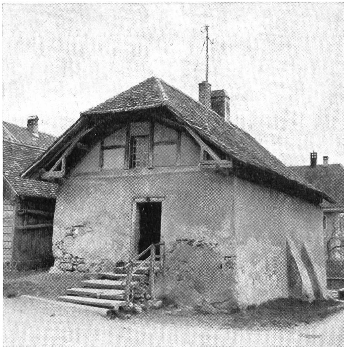
Abb. 4. Gemeinde-Ofenhaus in Salvenach (Kat. Nr. 38). Grosser Steinbautyp mit Fachwerkgiebel. Offener Dachvorsprung mit Flugspärren.
