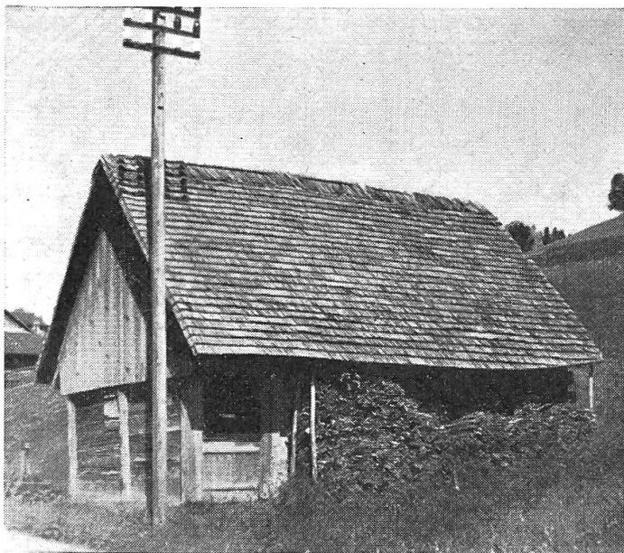
Abb. 4. Einraum-Ofenhaus. Holzbau (Typ Nr. 7, s S. 77). Reiner ursprünglicher Typ mit Schindeldach. Guggisberg. Abgebrochen.
