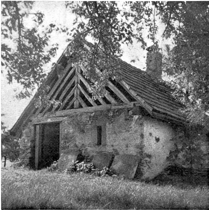
Abb. 9. Einraum-Ofenhaus, wie Abb. 8. Vorderfassade. 17./18. Jh. (?) Forst. Ofenhausverzeichnis Nr. 31.
