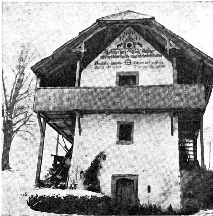
Abb. 5. Ofenhaus (Typ 5, s. S. 77) beinahe turmartig hochgezogen, im Erdgeschoss Tonnenkeller, im ersten Stock Ofenraum (Ofen kürzlich herausgerissen), im zweiten Stock Kornkästen. Blumenstein, dat. 1741. Ofenhausverzeichnis Nr. 18.
