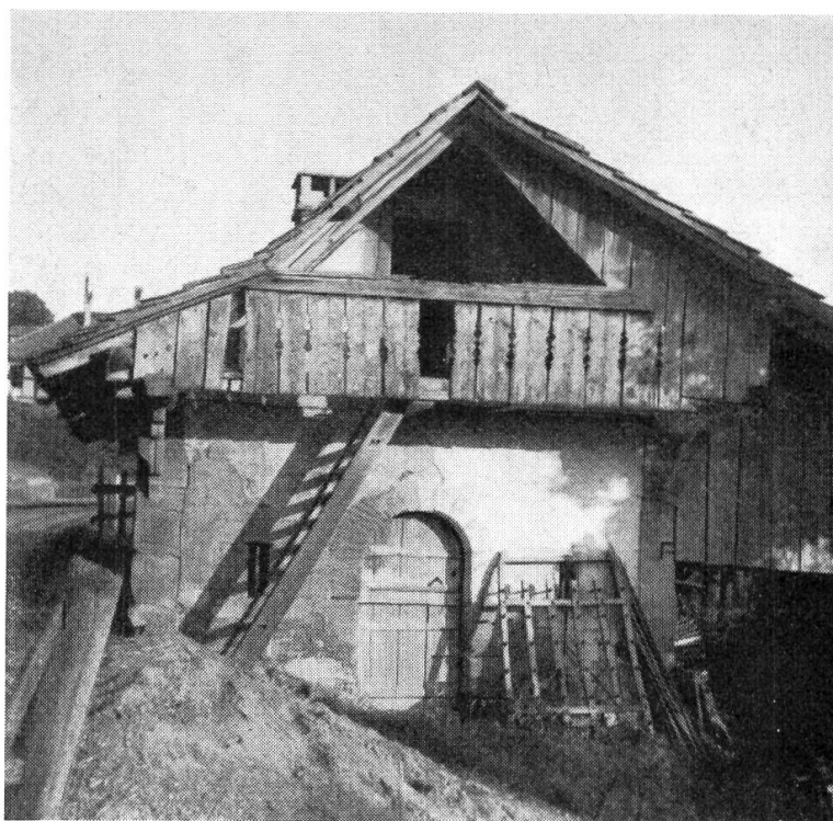
Abb. 1. Backofenhaus Moos/ Schwarzenburg, datiert 1781, mit Obergeschoss, in dem noch Fächer für Getreideeinlage- rung vorhanden sind. Seit 1953 wird darin nicht mehr gebacken. Der neue Pächter will aber das Backen wieder aufnehmen. Photo Währen.
