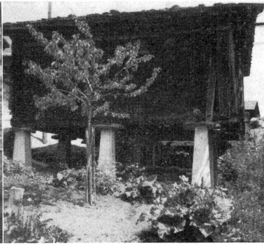
Stadel auf Mäuseplatten, darunter Betonpfähle Ferden, Löttschental
