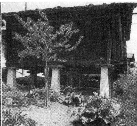
Stadel auf Mäuseplatten, darunter Betonpfähle Ferden, Lötschental
