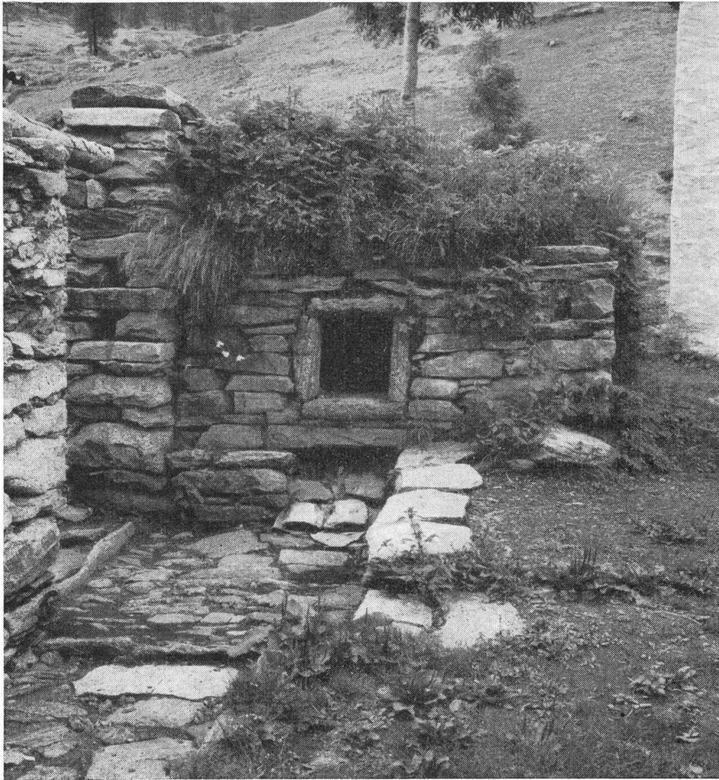
Der letzte der drei Backöfen von Bosco Gurin. Bis ca. 1890 im Gebrauch. Standort: hinter dem «Walserhaus». Gesamte Breite (ohne hervorstehende Mauer der linken Seite) 217 cm. Breite des Einschussloches 34 cm, Höhe 39 cm. Photo: Franz Tomamichel
