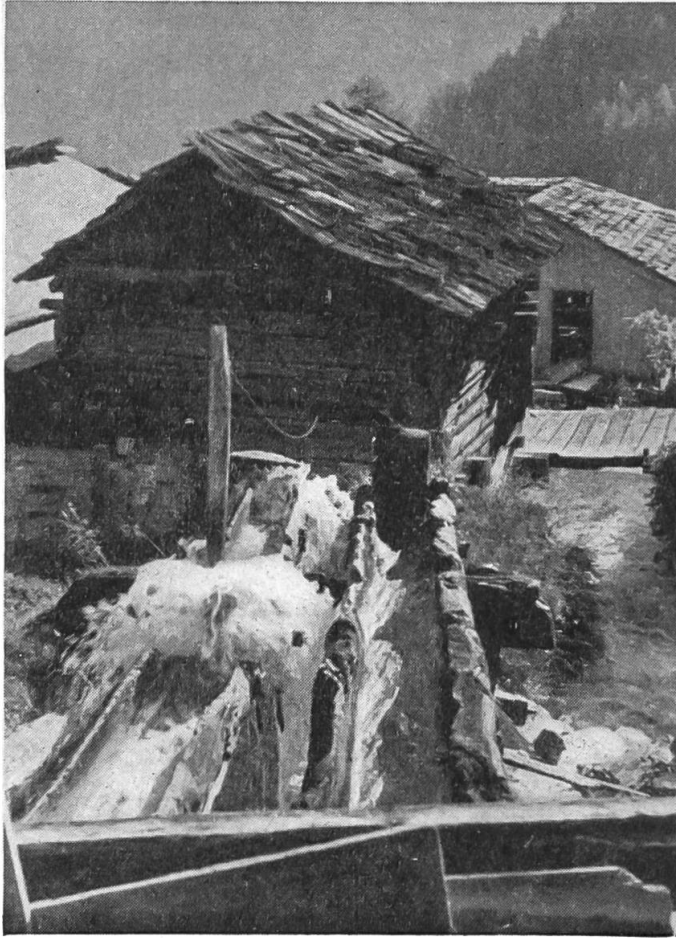
Abb. 1: Gemeindemühle in Grimentz; zwei Schusskennel, links geschlossene, rechts offene Schleuse
