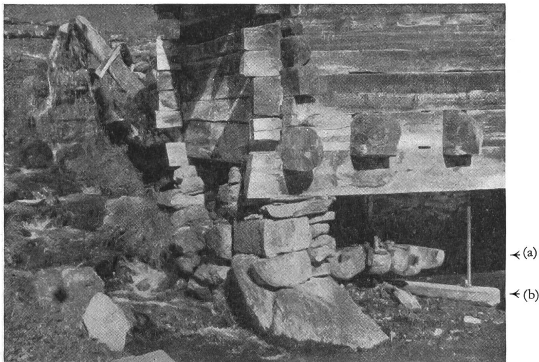
Abb. 2 : Kundenmühle in Verbier mit horizontalem «Löffelrad» (a); Steg, der das Rad trägt (b); «Schusskennel» (c)
