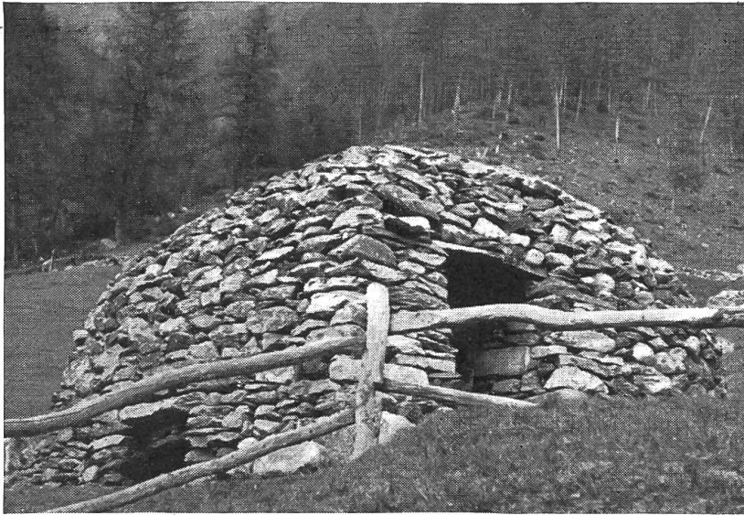
Abb. 8. Rundbau auf Alpe Braga, südöstl. Viano, 1700 m ü. M. mit Aufgliederung des Innenraumes in Stall und Scheune (funktioniert als Casa rustica ).
