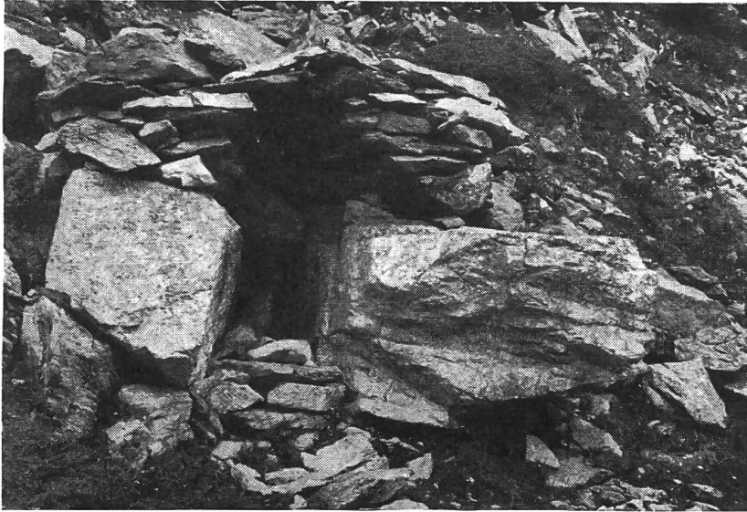
Abb. 7. Hirtenunterstand bei Plan della Teggia im Val Lagonè, 2100 m ü. M. an der Forcola di Livigno. Zeigt das Bauprinzip des falschen Gewölbes in primitivster Form.
