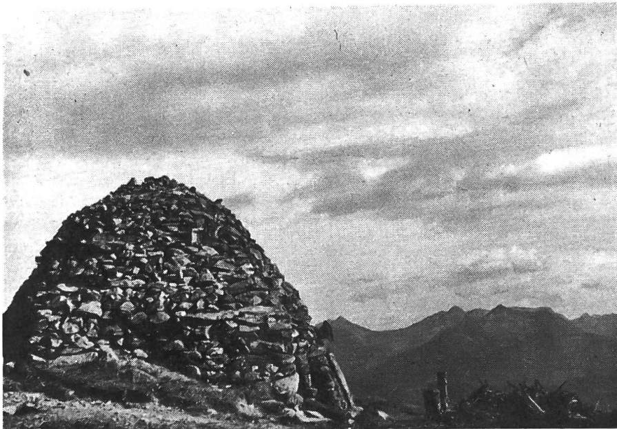
Abb. 10. Rundhütte auf Alp Grumo oberhalb Viano im Puschlav. 1950 m ü. M. Einzigiger, jetzt noch Wohnzwecken dienender Rundbau.
