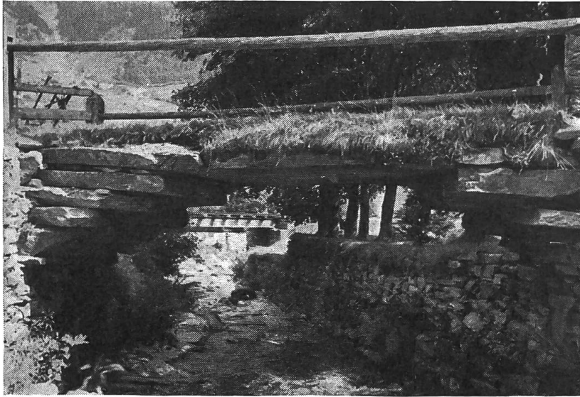
Abb. 6. Brücke bei Spineo, 1 km südlich Poschiavo, führt über den aus dem Val d'Orse kommenden Bach. Sie zeigt sehr schön das Prinzip des „falschen“ Gewölbes.
