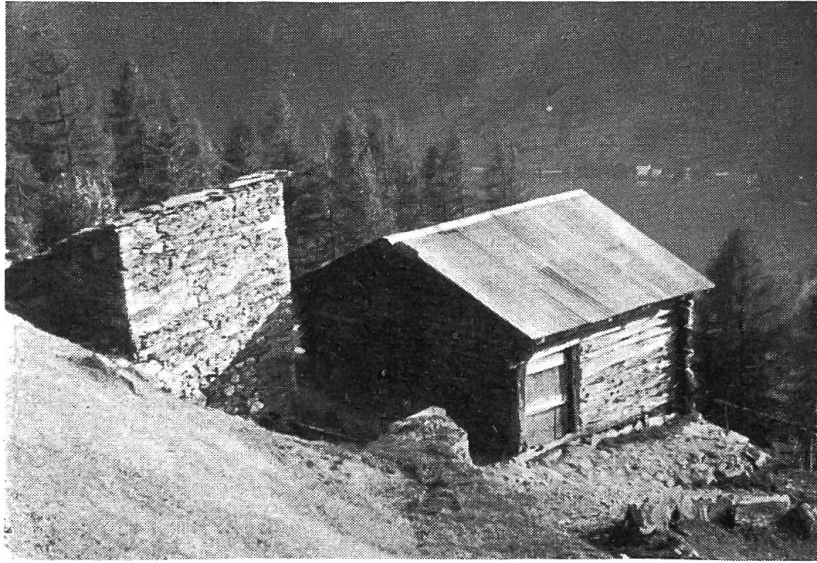
Abb. 4. Maiensäss Tiglieu, ca. 1400 m ü. M. oberhalb Cantone am Puschlaversee. Primitive Bauformen. Rechts Blockbau (Gaden) auf Mauersockel, der den Stall umschliesst. Satteldach ausnahmsweise aus Blech. Links: Pulldachhaus mit Küche und einem Raum im Erdgeschoss ( Cortile ). In dieser Siedlung sind die beiden Elemente der Casa civile und der Casa rustica , die wir bei Abb. 1—3 zu einer Einheit vereinigt sehen, noch getrennt.
