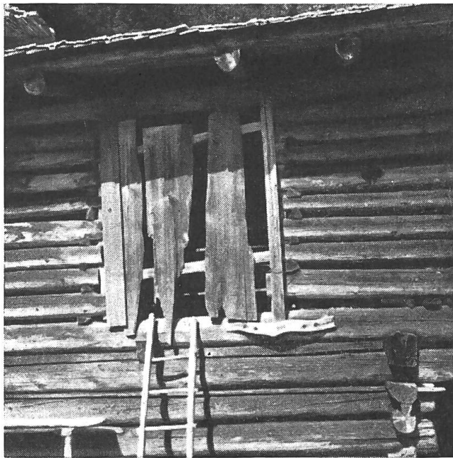
Abb. 8. Heimviehstall in der Melcheten; ein gebogener Ast als Angel der Scheunentüre.
