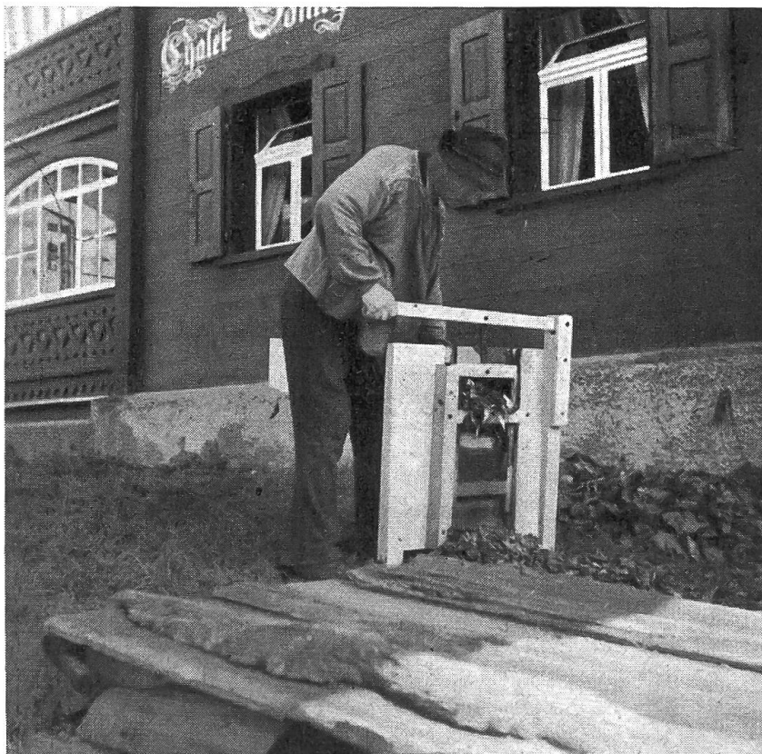
Abb. 1. Blaktenschneidmaschine (selbst hergestellt) aus Klosters-Aeuja. Im Vordergrund zugedecktes Brüejiloch.
