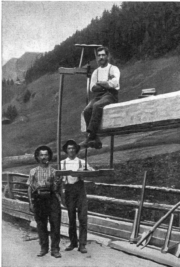
Abb. 1. Trentinersäge aus dem Goms.
