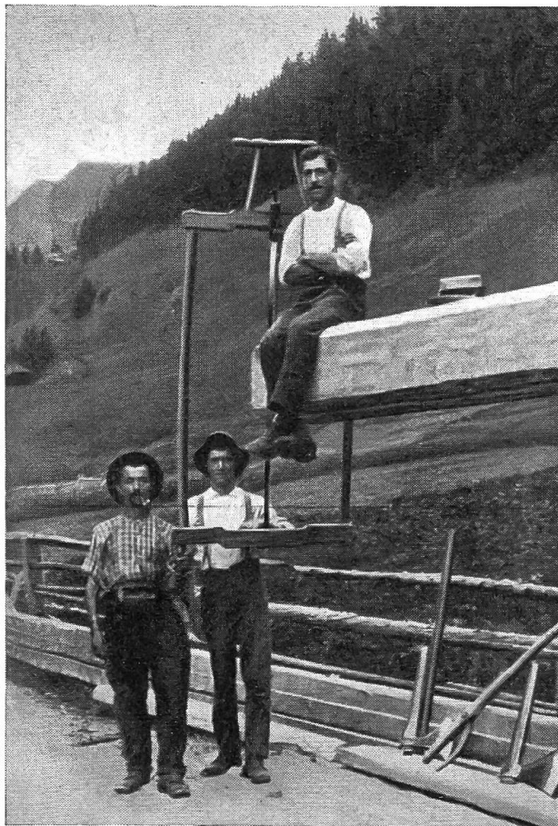
Abb. 1. Trentinersäge aus dem Goms.
