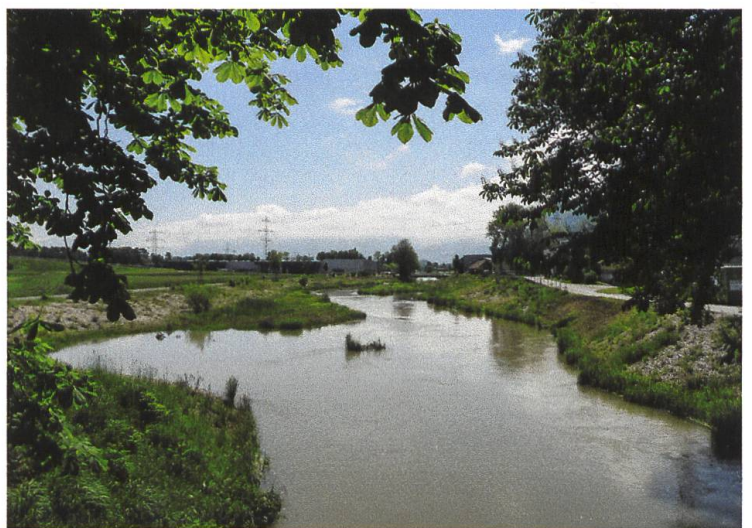
Abbildung 3: Blick auf revitalisierten Abschnitt von der Brücke Stöcken flussaufwärts zur Brücke Industriestrasse, am rechten Bildrand ARA Rüthi (km 19.625, 4. Juni 2010).
