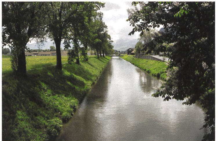
Abbildung 2: Blick von der Brücke Stöcken flussaufwärts zur Brücke Industriestrasse, am rechten Bildrand ARA Rüthi (km19.625, 19. Mai 2006).
