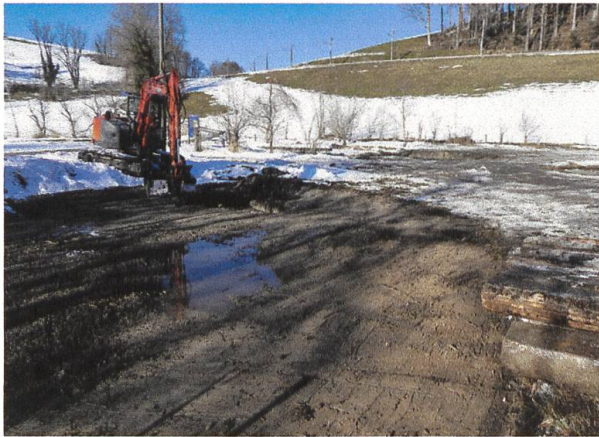
Abbildung 6: Aufwertung des flachen Tümpels. Die Arbeiten erfolgten im Januar 2022.
