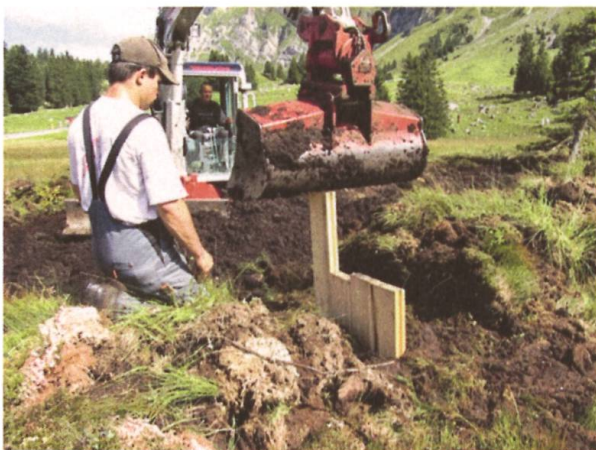
Abbildung 11: Einbau von Holzspundwände in die Entwässerungsgräben im Moor (Bruno Vattioni).
