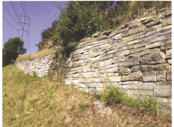
Abbildung 8 Weil Teile der alten Trockenmauer eingestürzt waren, wurde diese in freiwilliger Arbeit wieder aufgebaut. Dafür boten sich Steinreste aus dem Staader Steinbruch Bärlocher an. Aufnahme: Gieri Battaglia.
