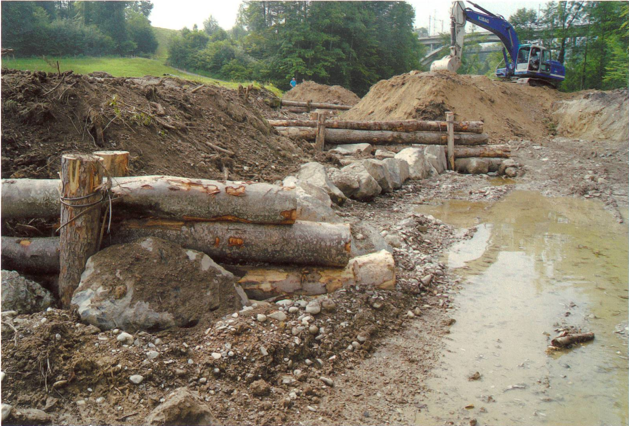
Abbildung 4: Holzbuhnen am rechten Ufer des alten Glattlaufes lenken das Wasser um und schützen das angrenzende Wiesland.
