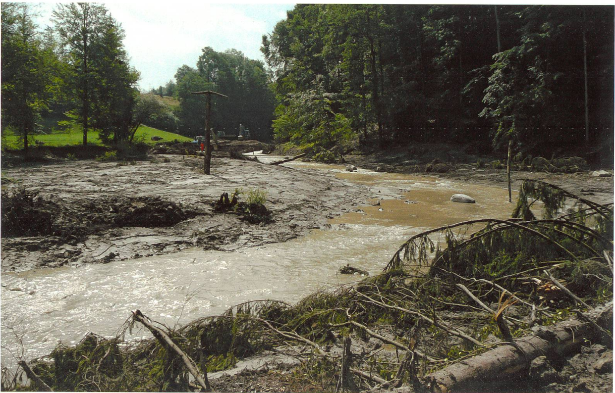
Abbildung 7: Die Flutung des neuen Auengebietes. Im Vordergrund Raubäume zum Schutz des abgelagerten Materials.
