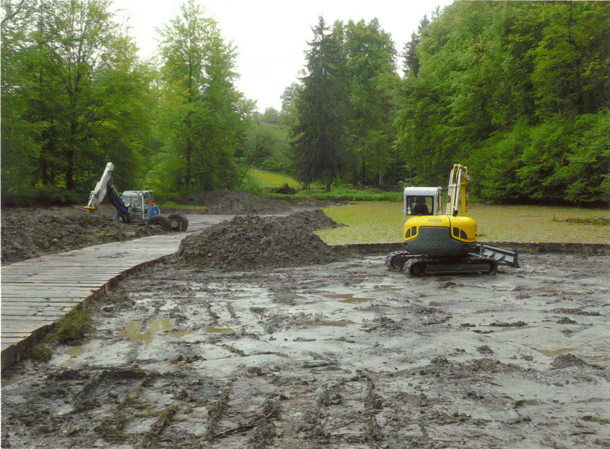
Abbildung 3: Bauarbeiten im abgetrockneten Weiher.
