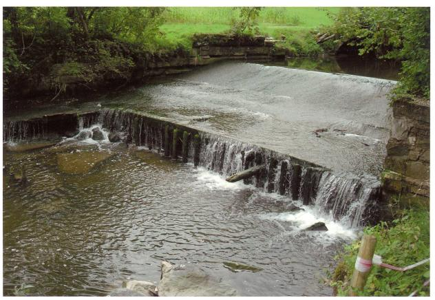
Abbildung 2: Oberes Stauwehr Isenhammer: Ein Betonwehr von 1.8 m Höhe verhindert seit etwa 150 Jahren die Wanderung von Fischen flussaufwärts.
