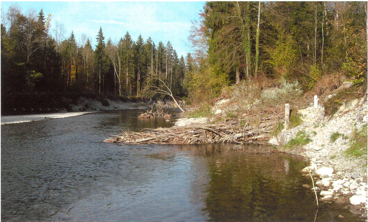
Abbildung 5: Mittlerer Teil der Auenstrecke flussabwärts, mit Holzbühne am rechten Ufer (Streifen Nr. 15 mit tiefem Kolk auf der Oberseite und tiefer Rinne in Fließrichtung am Bühnenkopf), am linken Ufer Streifen 11–14.
