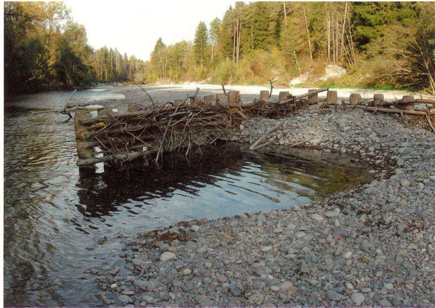
Abbildung 7: Oberster Abschnitt der Auenstrecke mit der eingebauten Palisadenwand zur Ablenkung der Strömung der Thur. Auf der linken Seite hat sich ein tiefer Kolk ausgebildet, die rechte Flussseite ist aufgelandet und liegt trocken. Im Kolk vor der Palisade hat sich Totholz angesammelt, dort wurden 80 Fische gefangen. Am linken Ufer befindet sich der Streifen 19 (Ufer mit einzelnen umgestürzten Bäumen = Totholz).
