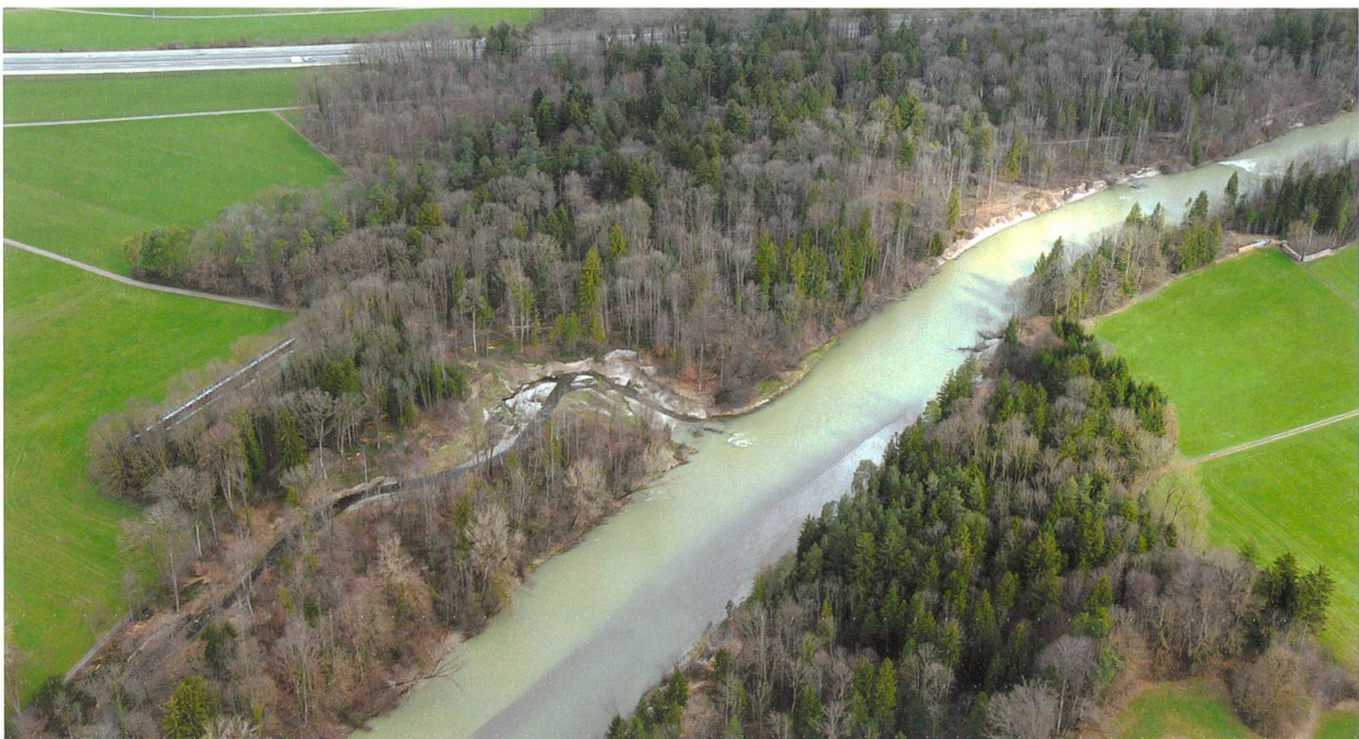
Abbildung 4: Mündung Alpbach nach der Renaturierung. (Foto Tiefbauamt Kt. SG)
