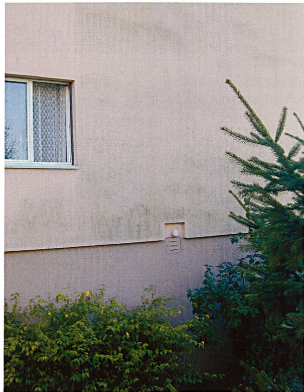
Abbildung 8: Fassadenbewuchs einer verputzten Aussenwärmedämmung. Bild M. Nay.
