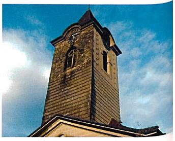
Abbildung 6: Dem Wetter ausgesetzte Westfassade eines Kirchturms aus Naturstein.
