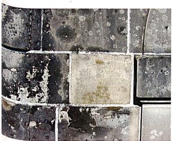
Abbildung 7: Reinigungsprobe vor/nach Bewuchsentfernung an der Fassade von Abbildung 6.
