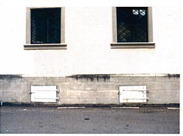
Abbildung 5: Der kleine Gesimsvorsprung der Fenster verhindert «schwarzes» Pilz- und Algenwachstum auf dem Mauersockel.
