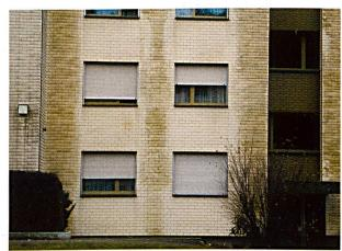
Abbildung 4: An der hinterlüfteten Fassade aus Faserzement-Schindeln steigt nachts kalte Aussenluft vor und hinter der vorgehängten Fassade hoch und kühlt die Fassade auf Umgebungstemperatur.
