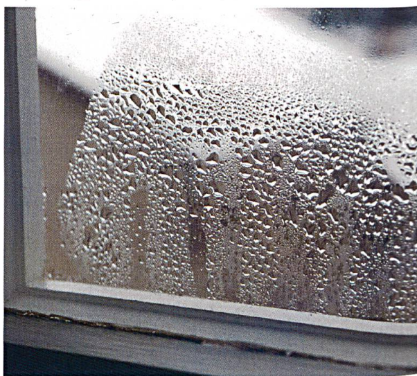
Abbildung 11: «Schwitzende» Fenster zeigen eine zu hohe Wohnungsfeuchte und Gefahr der Holzzerstörung am Fenster an.
