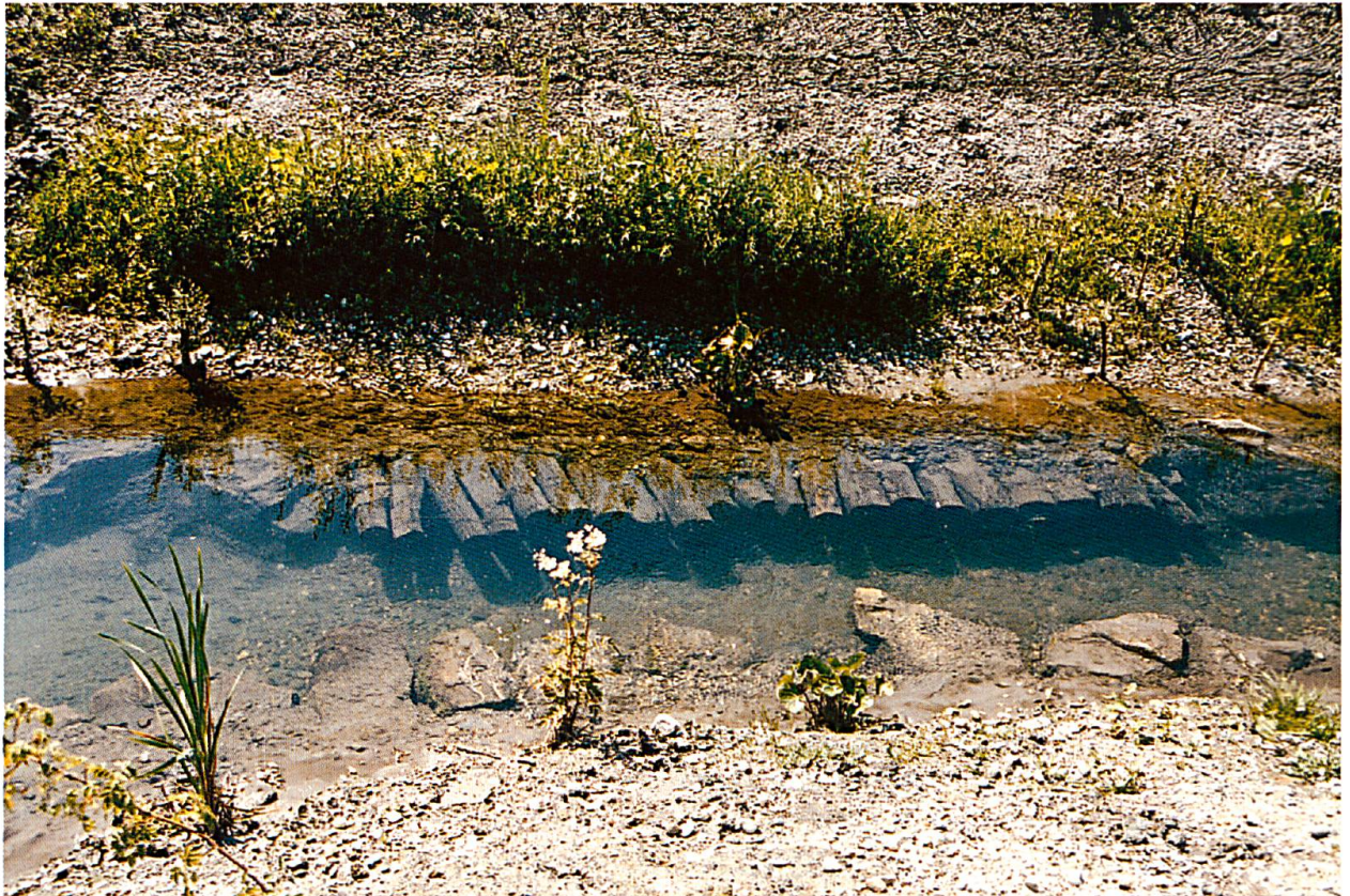
Abbildung 5: Fischunterstände an der renaturierten Böschaach in Widnau.
