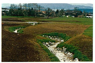
Abbildung 4: Der offenglegte und geschwungen geführte Wantenbach in Zuzwil
