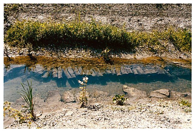
Abbildung 5: Fischunterstände an der renaturierten Böschaach in Widnau.
