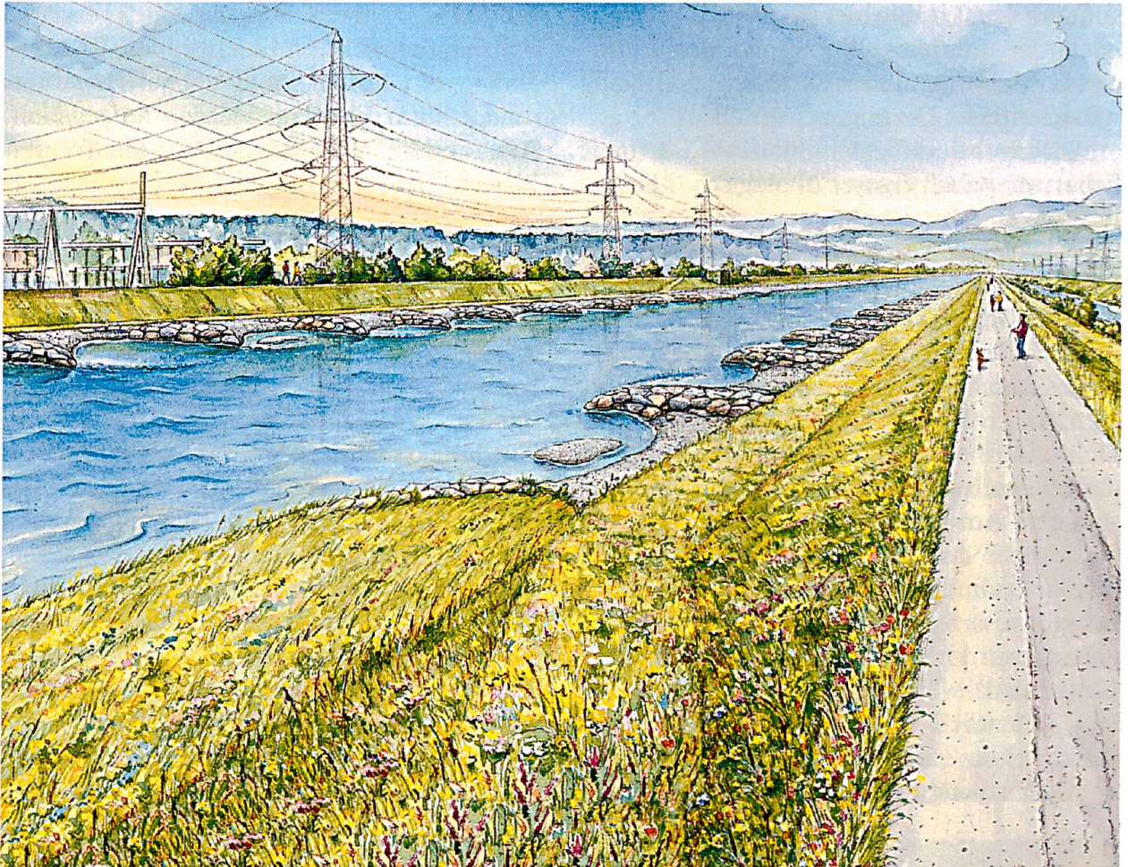
Abbildung 12: Hochwasserschutz Linth 2000: Mit Bühnen strukturierter Linthkanal zwischen Giessen und Grynau. Bild: UNSERE LINTH, Nr. 1 / Herbst 2005.
