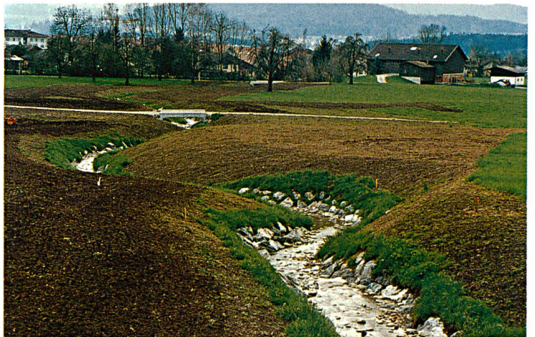
Abbildung 4: Der offengelegte und geschwungen geführte Wantenbach in Zuzwil
