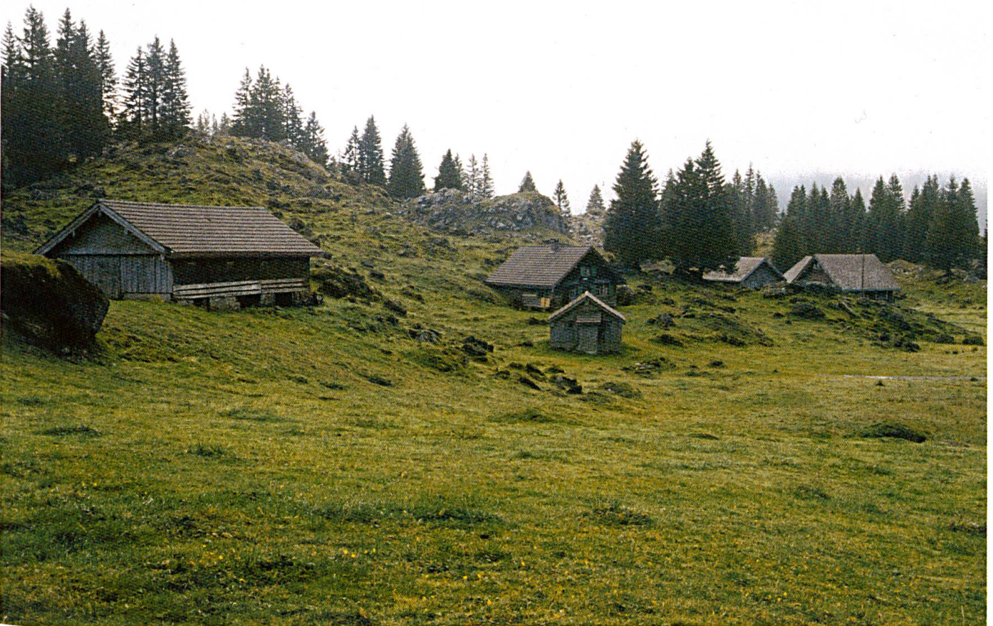
Abbildung 7: Alpgebäude Zweigemmer in typischer Anordnung als Ensemble mit Hütte (Mitte oben), Kuhstall (links) und Schweinestall (Mitte, klein). Foto: ARNAL AG, Herisau.
