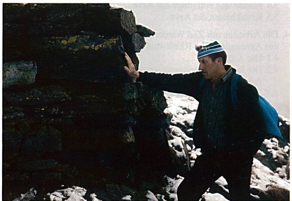
Abbildung 1: Reste der Trocken- mauer des Hochofens unterm Wänglispitz auf 2350 m ü.M.. Hier wurde Eisen aus dem Erz des Wänglispitzes verhüttet. Foto: Theo Gerber.
