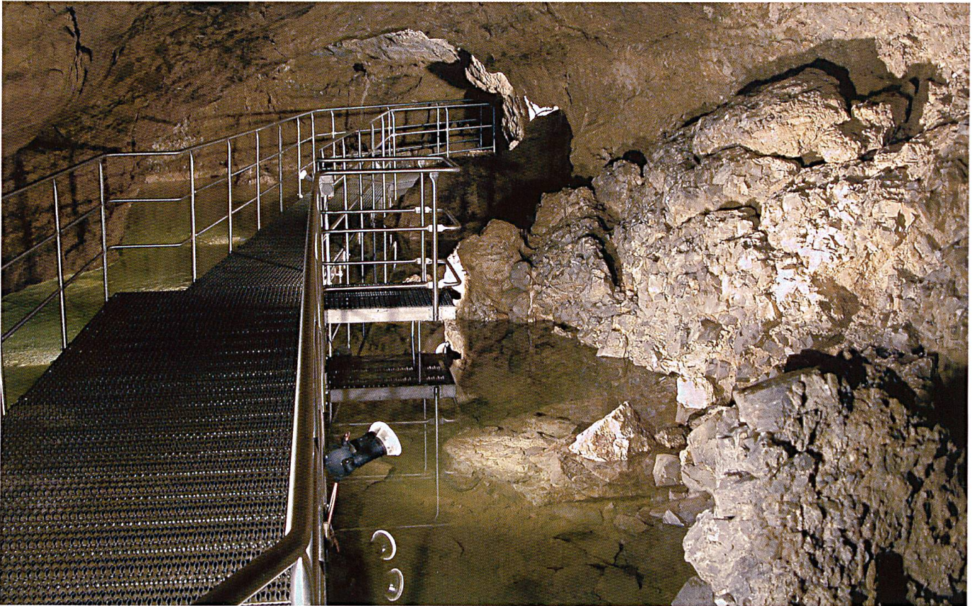
Abbildung 6: Erste Halle nach dem Abtrag der Bodensedimente. Links der künstlich gestaute See, rechts die freigelegten Boden- und Wandpartien mit den vielen Calcitkristallen.
