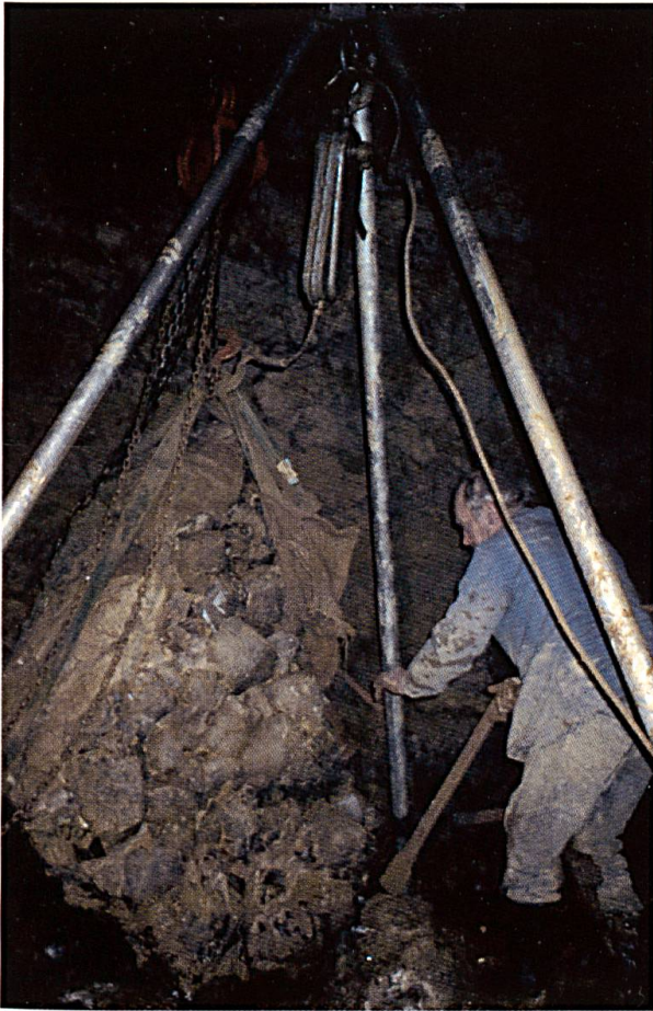
Abbildung 8: Anheben und Verschieben eines grossen, mit vielen Calcitkristallen überwachsenen Gesteinsblockes, welcher in der Ersten Halle anlässlich der Höhlensanierung 2001/2002 geborgen wurde.
