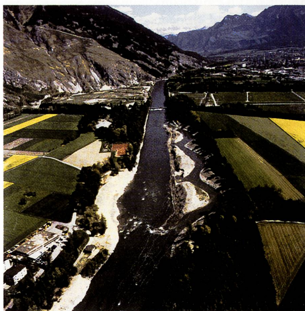
Abb. 3. Rheinaufweitung zwischen Chur und Felsberg (Baujahr 1994–1996). Foto: Tiefbauamt Graubünden, Mai 1996.
