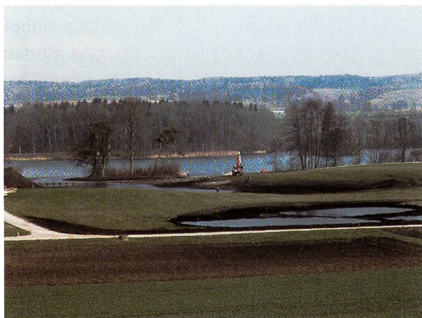
Abb. 2. Uferabflachung «Im Riet» mit zurückversetzten Amphibientümpeln.
