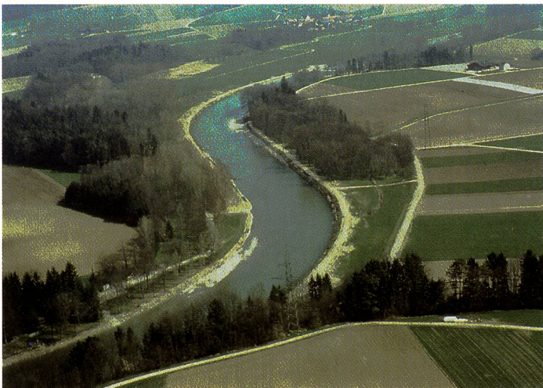
Abb. 5. Die Thur bei Gütighausen als Kanal 1982.
