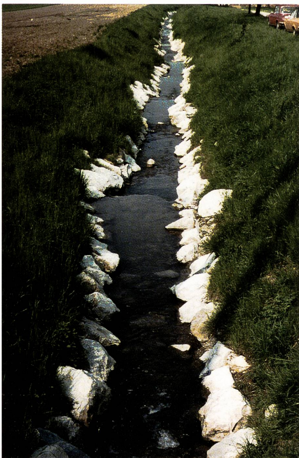
Abb. 2. Waltensteiner Eulach, von Adolf Huber und seiner Unterhaltsequipe anfangs der siebziger Jahre «unordentlich» ausgebauter Bach.
