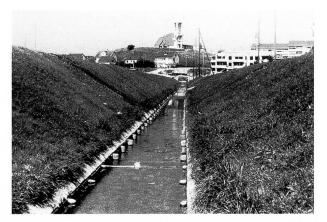
Abb. 1. Grendelbach Effretikon, ein «ordentlich» ausgebauter Bach.
