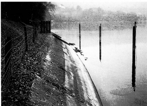
Abb. 2. Massive Betonplatte als Erosionsschutz.
