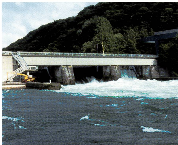
Abb. 1. Wehr des Kraftwerkes Schaffhausen vom Unterwasser her gesehen.
