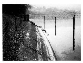
Abb. 2. Massive Betonplatte als Erosionsschutz.
