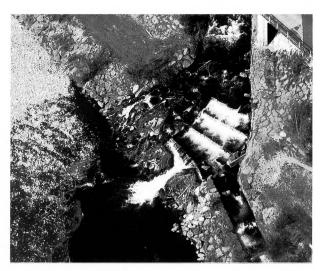
Abb. 1. Die nicht niveaugleiche Mündung des Saarkanals unterhalb Sargans verhindert den Fischaufstieg in das Seitengewässer. (Foto: P. Rey).
