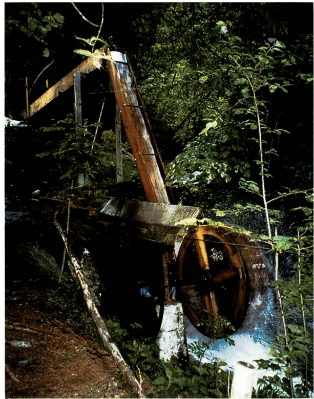
Abb. 2.1. Mulin Schnaus bei Ilanz (historisches Objekt). Wasserrad aus Holz mit Blechschaufeln als Antrieb für eine mechanische Werkstätte mittels Seiltransmission (Foto Ueli Giger, Schnaus).
