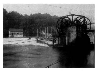
Abb. 2.2. Moserdamm in Schaffhausen, Inbetriebnahme 1866; links das Maschinenhaus, Mitte der Damm und das Wehr, rechts das Getriebe für die Richtungsänderung der Seiltransmission (Foto Elektrizitätswerk Stadt Schaffhausen).
