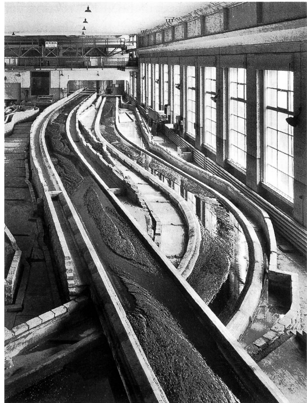
Abb. 1.7. Modelle des Mittelgerinnes des Rheins in der Versuchsanstalt für Wasserbau (VAW) der ETH Zürich, 1938 (Foto VAW).
