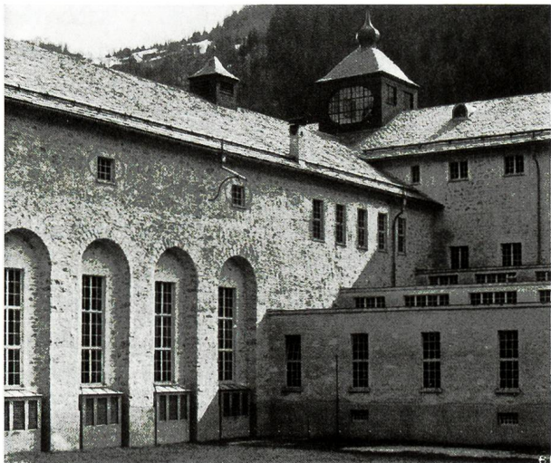
Abb. 2.3. Kraftwerkzentrale Küblis, Inbetriebnahme 1922. Teilansicht aus Norden (Fotoarchiv Rätiaenergie, Küblis).
