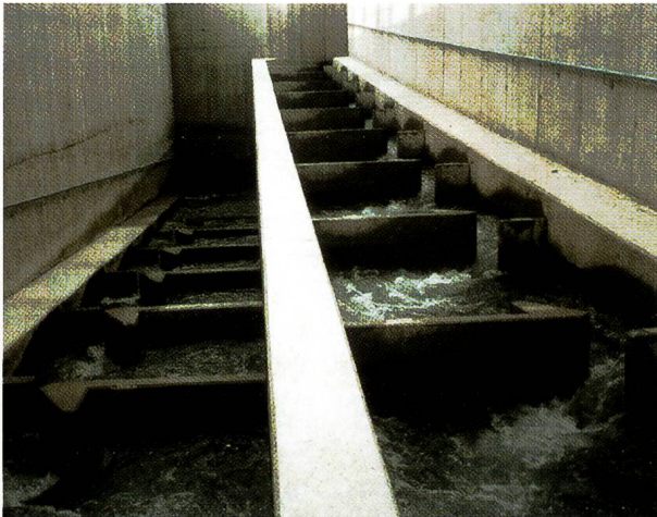
Abb. 2. Dank dem Bau einer Fischtrappe bei Domat/Ems konnte die Seeforelle gerettet werden. Foto: Amt für Jagd und Fischerei Graubünden.
