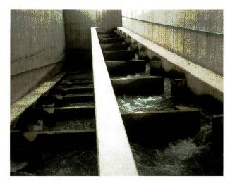
Abb. 2. Dank dem Bau einer Fischtreppe bei Domat/ Ems konnte die Seeforelle gerettet werden. Foto: Amt für Jagd und Fischerei Graubünden.
