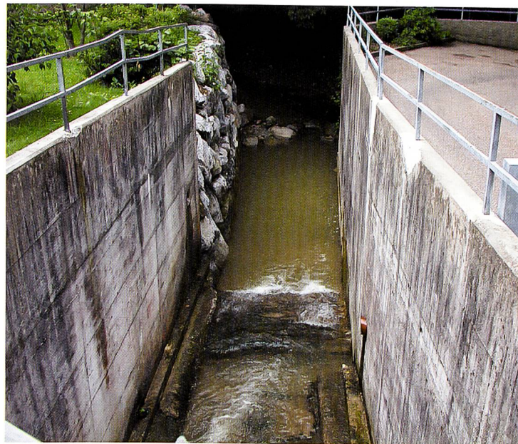
Abbildung 12: Der Einfluss des Rütibachs erfolgt über eine betonierte Rampe. Hier zeigt die Natur nur wenig Vielfalt. Foto Toni Bürgin.
