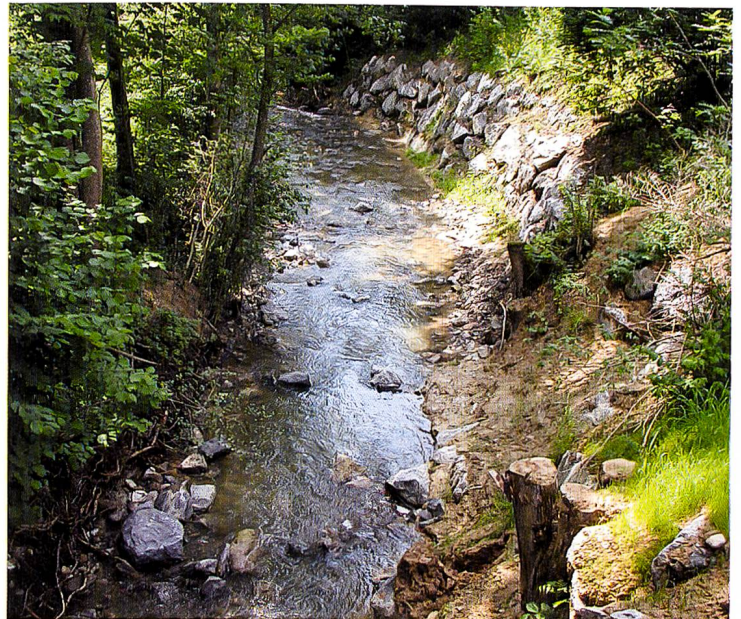
Abbildung 13: Naturnahe Bachverbauungen im Quartier St.Georgen tragen zu einer Erhöhung der Artenvielfalt bei. Foto Toni Bürjin.
