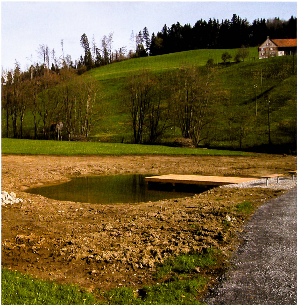
Abbildung 2: Schulweiher mit Beobachtungsplattform nach Fertigstellung.
