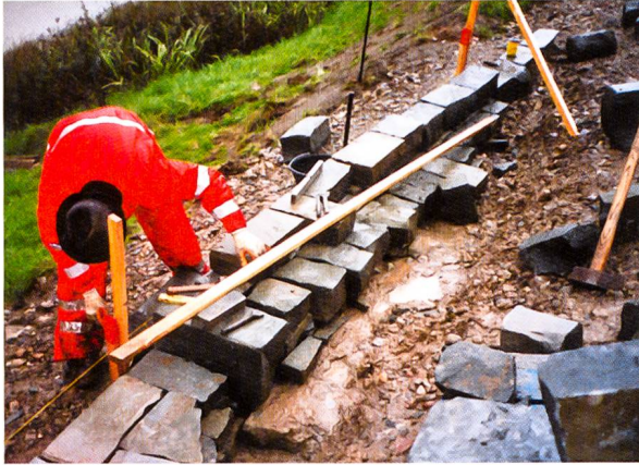
Abbildung 2: Handwerkskunst beim Mauerbau.
