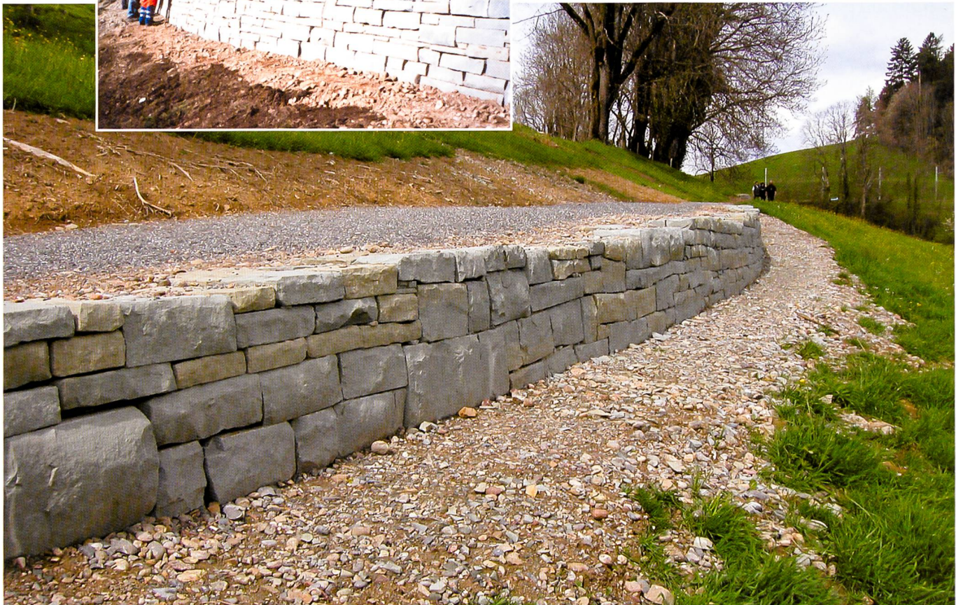
Abbildung 4: fertige Mauer, oberhalb der neue Weg, unterhalb Kiesflächen für Ruderalflora.
