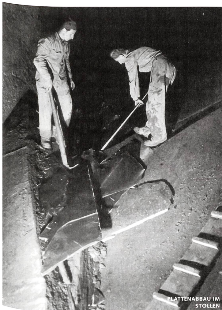
Abbildung 33: Plattenabbau im Stollen. Foto Stiftung Landesplattenberg.
