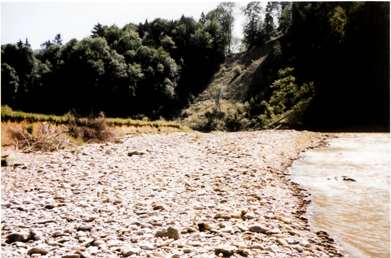
Abbildung 17: Sitterschlaufe südlich Waldburg. Bei extremen Hochwassern wird am Talboden des Gleithangs (links) erodiert. Am Prallhang im Hintergrund zeichnen sich Rutschungen ab. Foto E. Krays.
