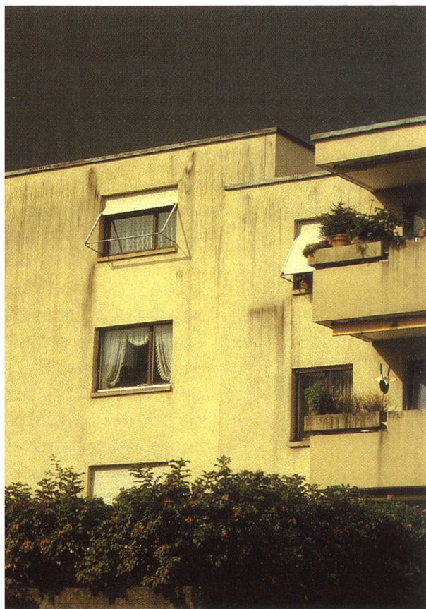
Abbildung 8: Bewuchs an verputzter Aussenwärmedämmung.
