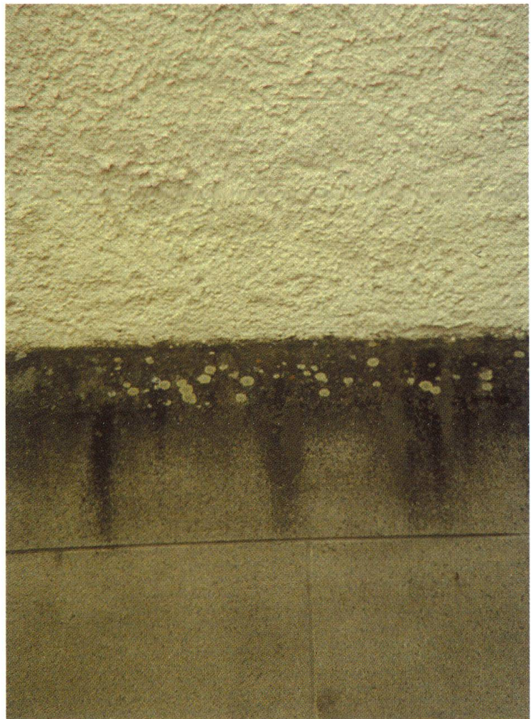
Abbildung 5: Bewuchs an Mauersockel.
