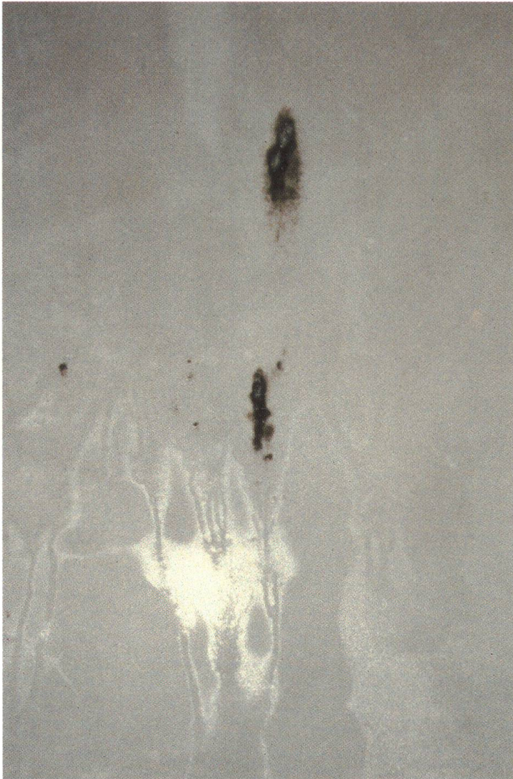
Abbildung 9: Trinkwasserspeicher mit Bewuchs.
