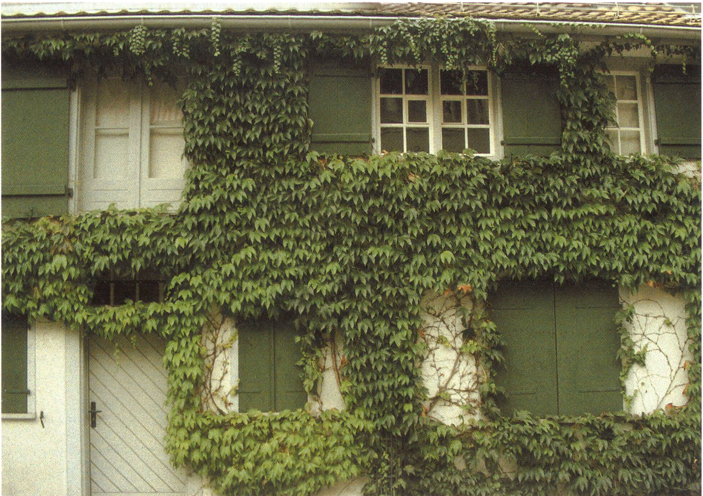
Abbildung 2: Bewuchs einer Fassade/ begrünte Fassade.
