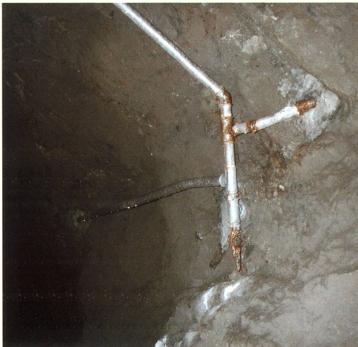
Abbildung 11: Gasfassung im Montpertjörisstollen.
