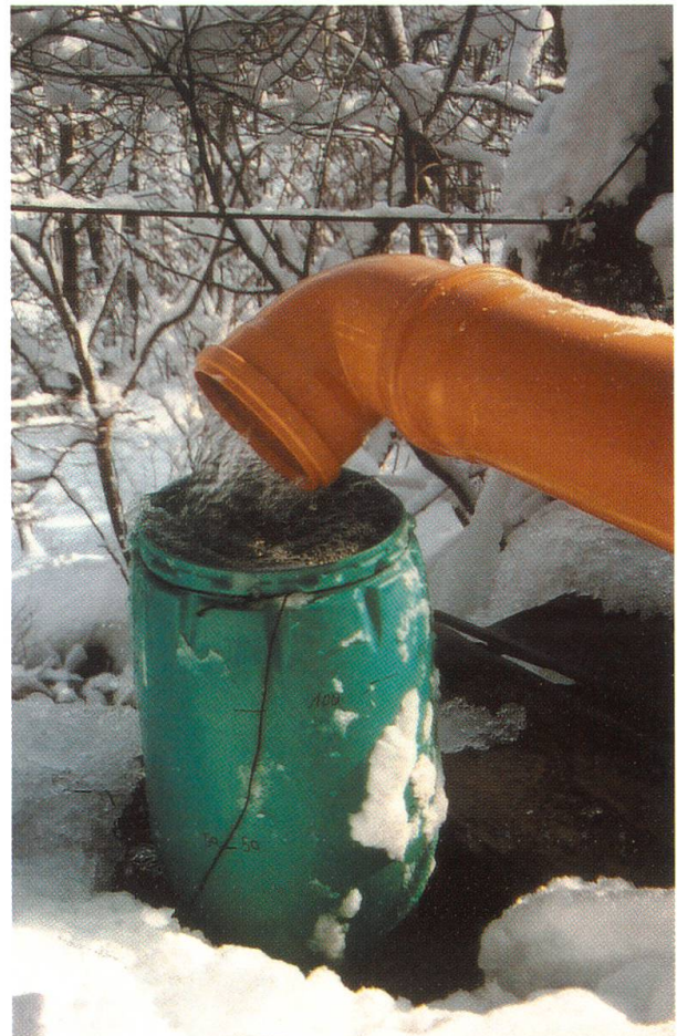
Abbildung 6: Wassererfassung mit dem Fass am Portal des Wolfslochsstollens.
