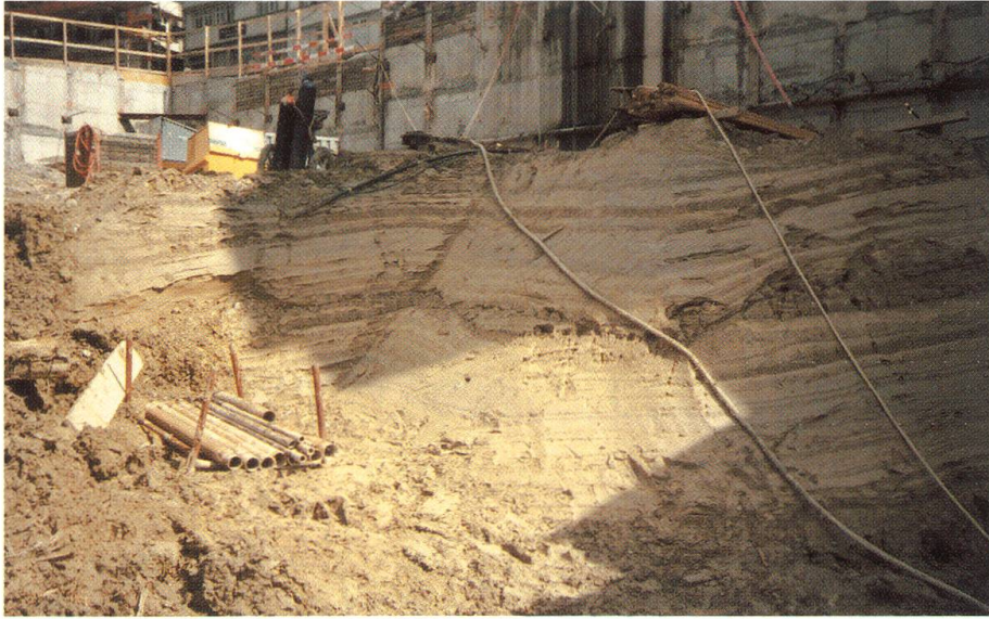
Abbildung 17: Baugrube der Kantonalbank Herisau. Bänder-tonartige Feinschichten von Silt und Ton belegen den eiszeitlichen Stausee mit Spiegelhöhe um 770 m im Feuerthalen-Stadium.
