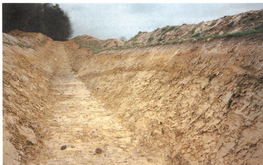
Abbildung 16: Kanalbau für die See- wasserleitung bei Alten- wegen südlich Abtwil. Im Vordergrund feinkör- nige Seeablagerungen unter Schwemmlehm und Bodenbildungen. Sie belegen mit einem Niveau um 645 m den Abtwiler Eisstausee in Stein am Rhein- Stadial W8. Die See- sedimente stossen im Hintergrund gegen eine Kuppe aus Grund- moräne. Foto E. Krayss.
