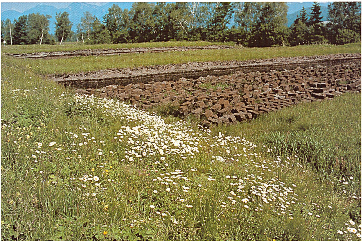
Abbildung 6: Der Torfabbau führt zu Kanten, Gräben und Schollenlagern und trägt zu einem reich strukturierten Gebiet bei. Jeder Riedstreifen hat eine andere «Geschichte» und weist dadurch eine andere Vegetation auf. (Foto: Ignaz Hugentobler)
