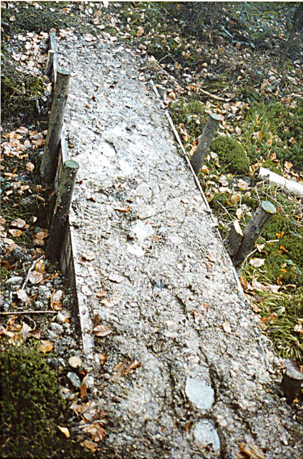
Abbildung 7: Neu errichteter Staudamm im Abflussgraben.
