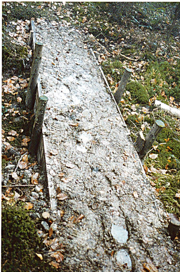
Abbildung 7: Neu errichteter Staudamm im Abflussgraben.
