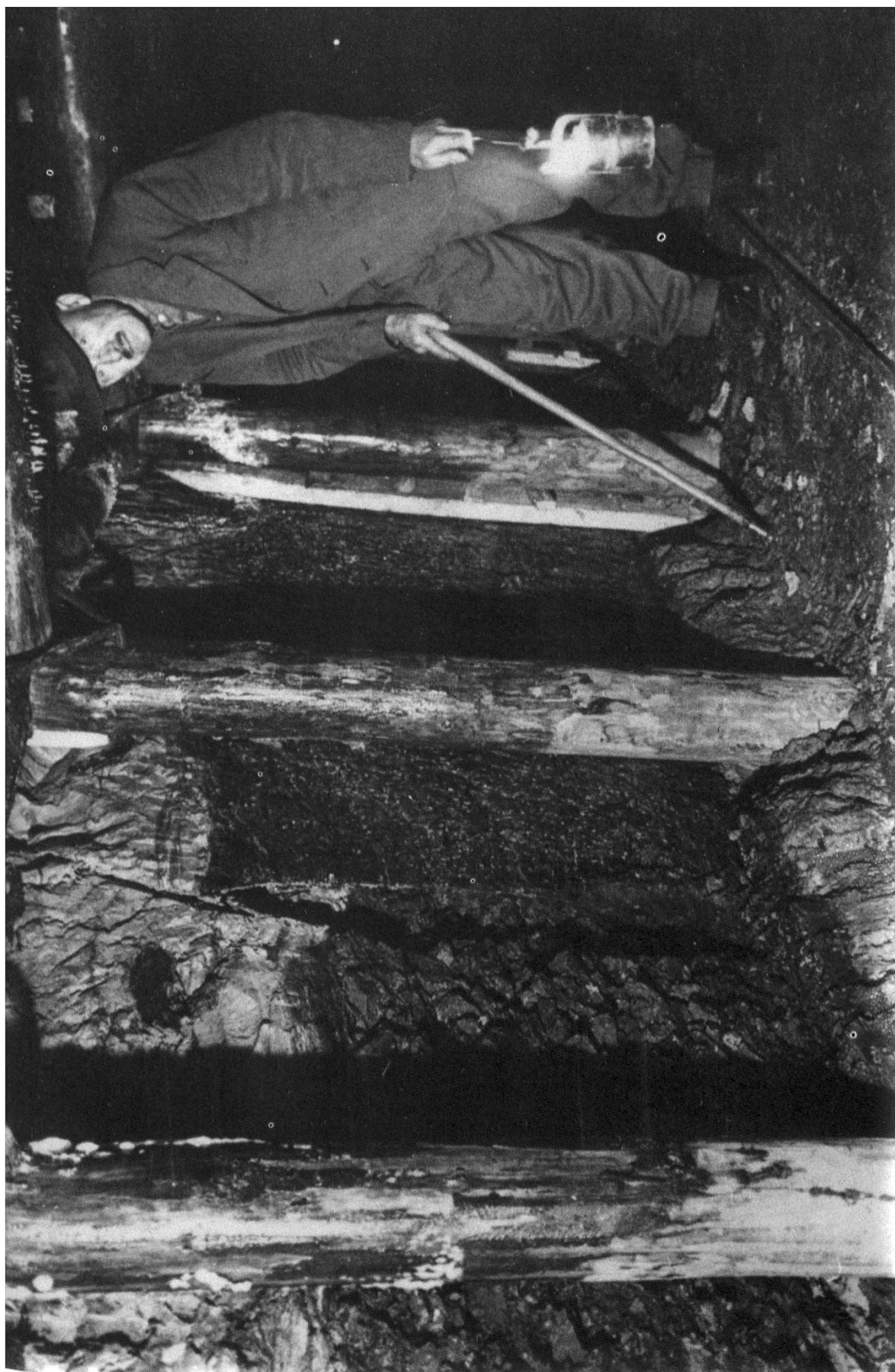
Abb. 11: Untertageabbau der Mörschweiler Schieferkohle am Schwärzebach im 2. Weltkrieg. Linkes Drittel: alter Mann, rechts davon intaktes Schieferkohleflöz (mit Jeremias Corazza). – Nach Unterlagen der Firma Corazza AG, St. Gallen.
