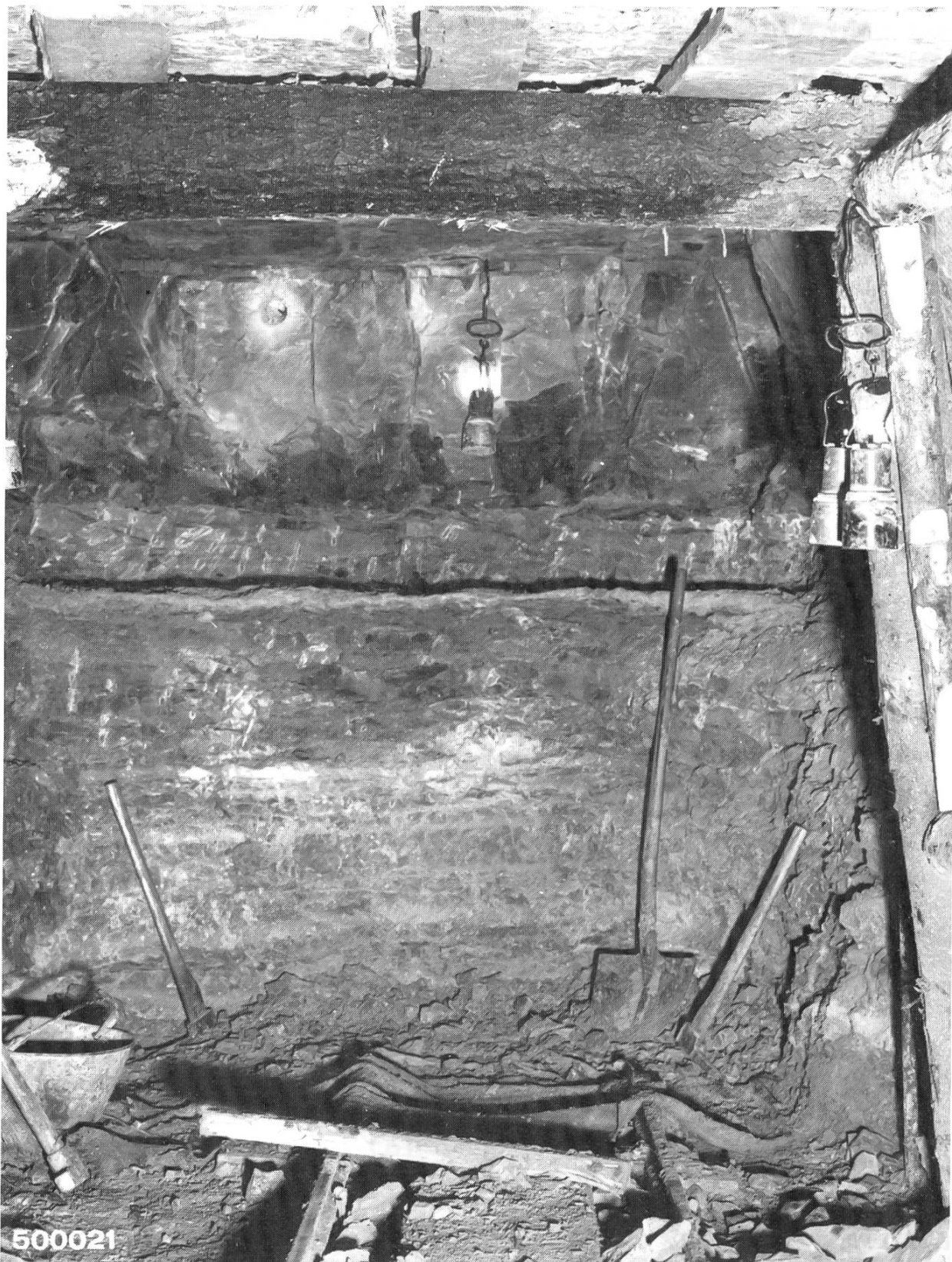
Abb. 14: Aufnahme der Stollenbrust im Bentonit-Probeabbau Bischofszell-Niederhelfenschwil, Winter 1949/1950. Die Bentonitschicht liegt in halber Höhe der Stollenbrust (oberes Ende Schaufelstiel); darunter fluvioterrestrische Mergel; über der Bentonitschicht vulkanischer Glasaschentuff (die Grubenlampe in der Mitte des Bildes hängt an einer scharfen, glatten Trennfläche zwischen zwei Tuffschichten, welche Fläche als Stollendach diente. – Werkphoto Georg Fischer AG.
