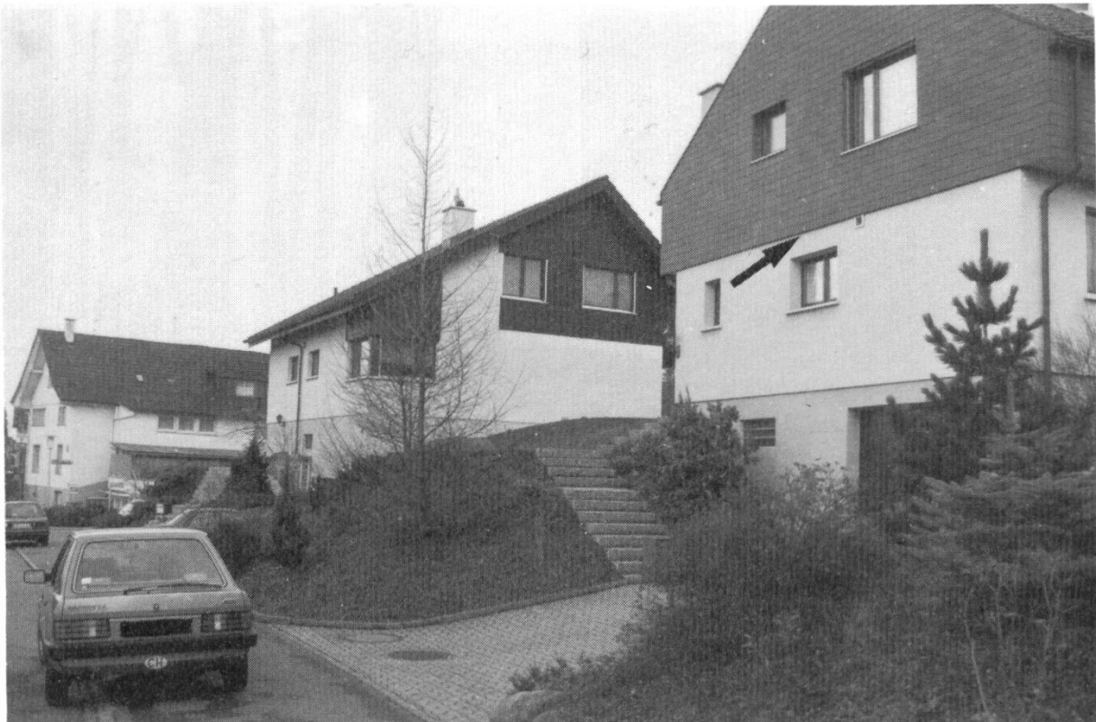
Bild 8: Sommerquartier der Zwergfledermaus hinter der Eternitverschalung eines modernen Einfamilienhauses.
