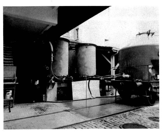
Abb. 10 Bypaßrohrleitung an Druckbehälterwaggon angeschlossen. Am Boden verlegt die Zufuhrleitung der Druckluft (2 atü) zu Druckbehälter und Ringdüse.
