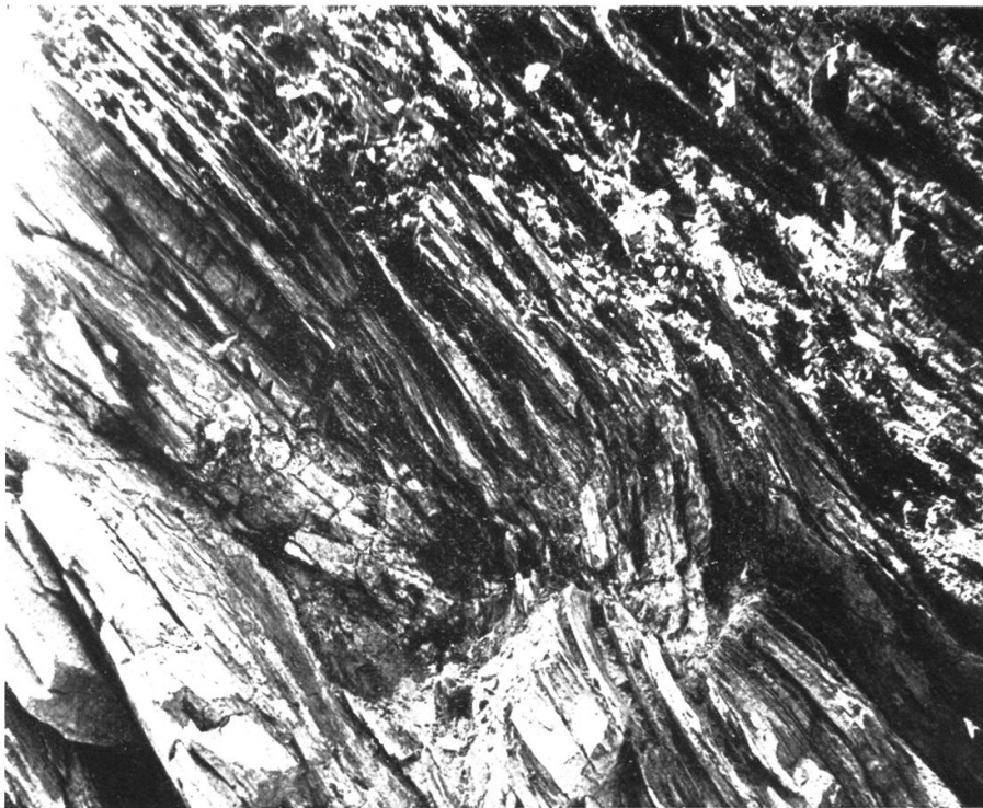
No. 4. Verwitterung des Serizitschiefers bei Hospental.
