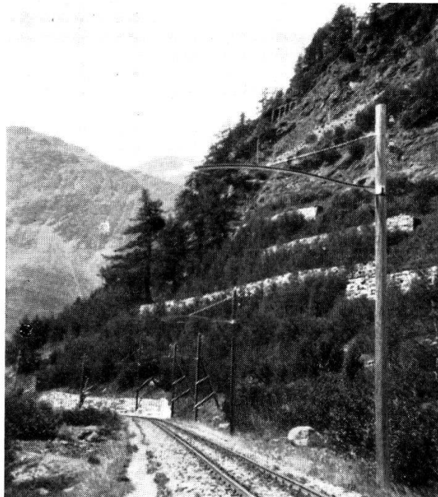
Abb. 7. Steilhang bei Stabline. Lawinenverbauungen. Aufforstung.
