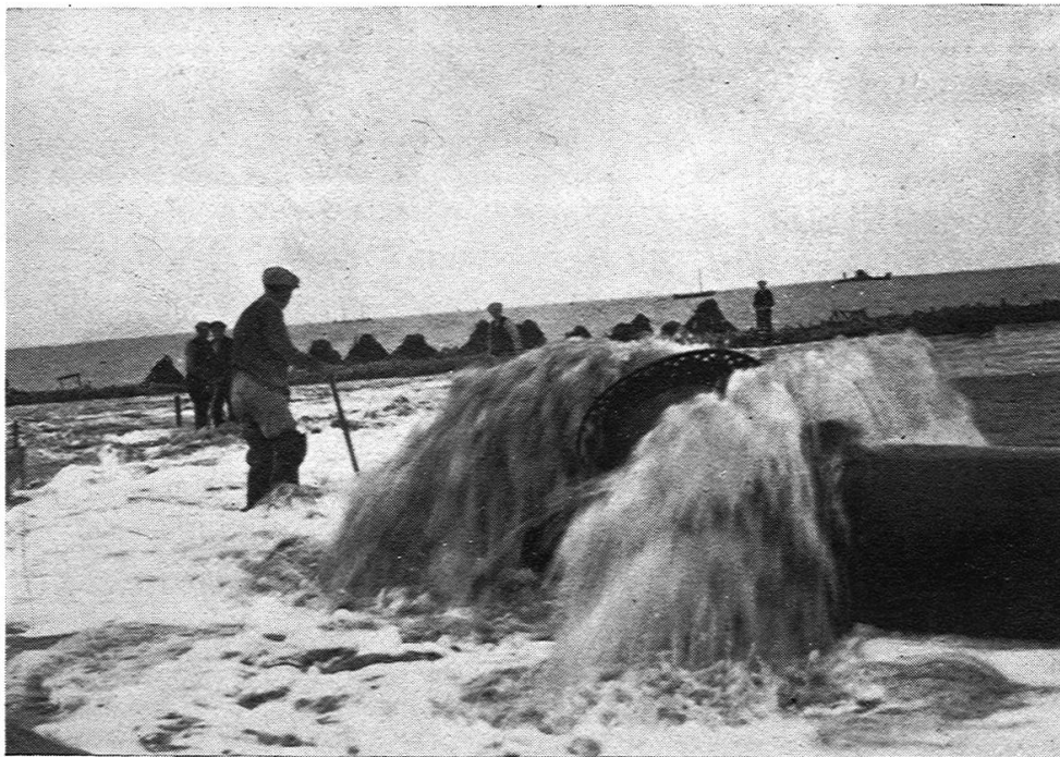
Fig. 7. Ende der Schwemmleitung für Sand. Länge 500 m, Röhrendurchmesser 60 cm. Aufnahmen von E. Leemann.
