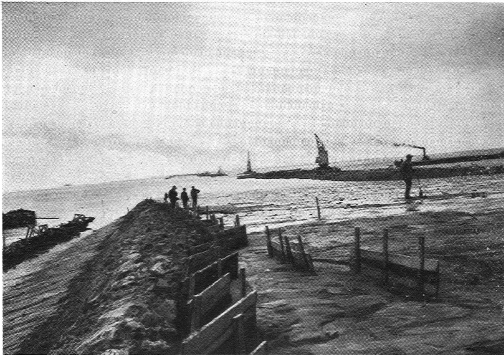
Fig. 5. Abschlussdamm bei Zurig. Dämme aus Mergel und Brettergestellen.
