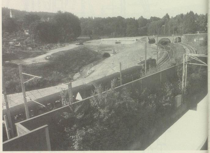
Materialdepot: Links und rechts der neu ausgebauten Steinach wurden die 42 000 m³ Stollenausbruchmaterial angelegt. Auf Förderbändern wurde das Material vom Stollenausgang zu dieser Deponie gebracht. Durch diese Deponiemöglichkeit konnten die Immissionen, verursacht durch den Abtransport des Materials mit Lastwagen, weitgehend ausgeschaltet werden. In der Bildmitte gut sichtbar die Regenbecken die zum grössten Teil bereits mit Material eingedeckt sind.
