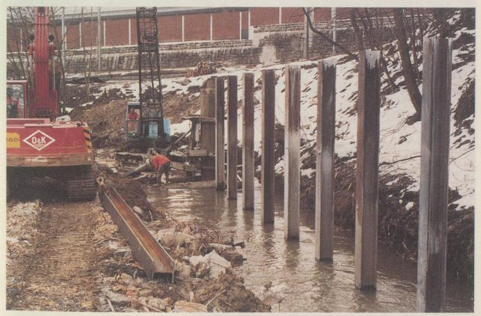
Rühlwand für den flutsicheren Bau des Steinachstollens. Die Träger wurden anschliessend ausgefacht und dahinter der Bahnhof für die Stollenbahn angelegt, in dem 42 000 m' Material umgeschlagen wurden.
