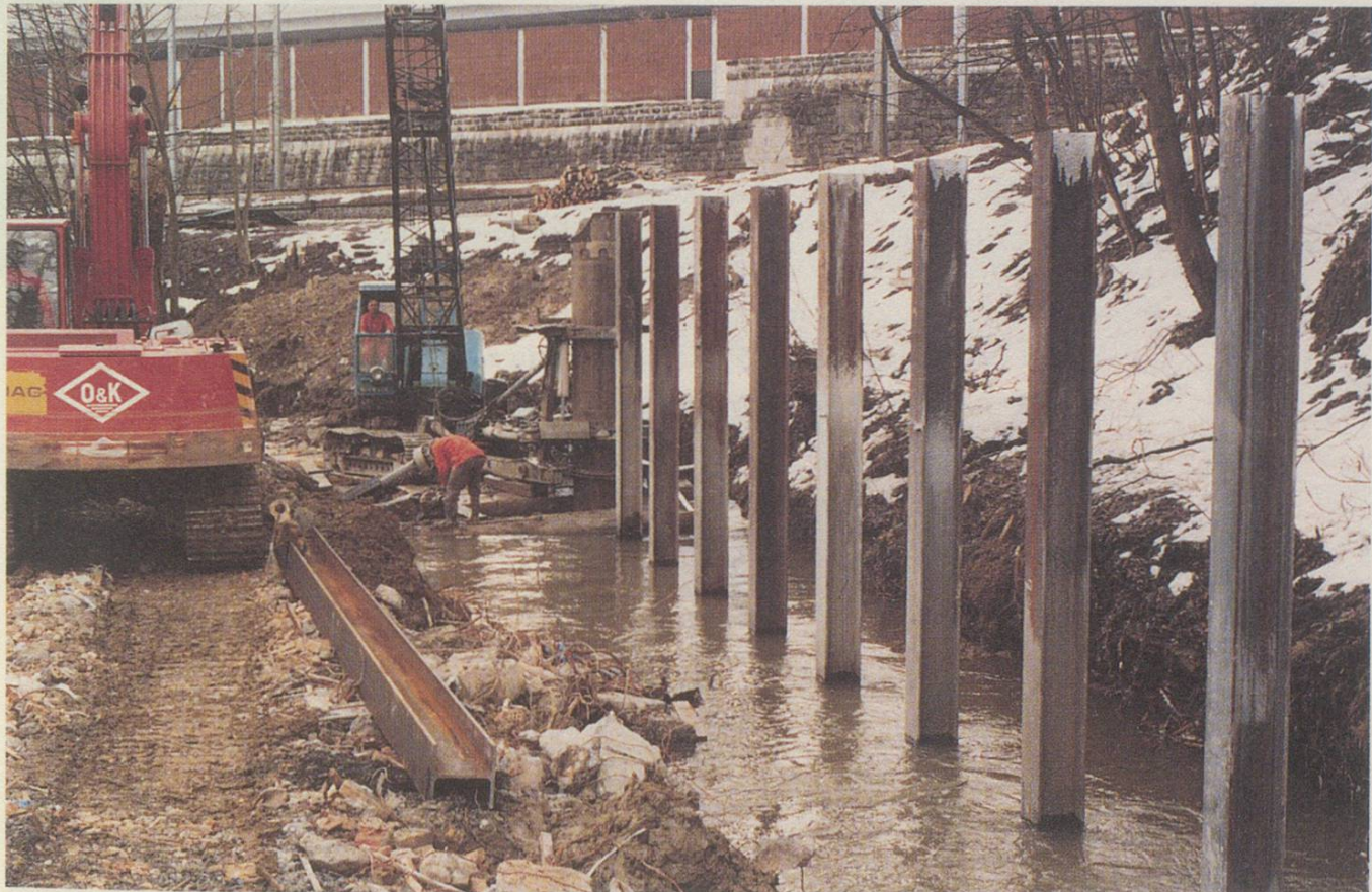
Rühlwand für den flutsicheren Bau des Steinachstollens. Die Träger wurden anschliessend ausgefacht und dahinter der Bahnhof für die Stollenbahn angelegt, in dem 42 000 m³ Material umgeschlagen wurden.
