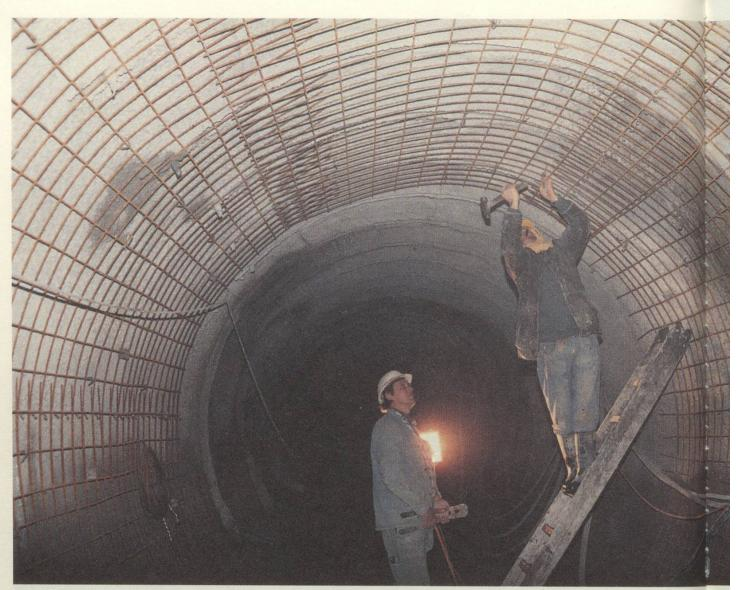
Endausbau: Hier werden Armierungsnetze befestigt, die später mit Beton überspritzt werden zur Sicherung der Stollenwände gegen Felseinbrüche.
