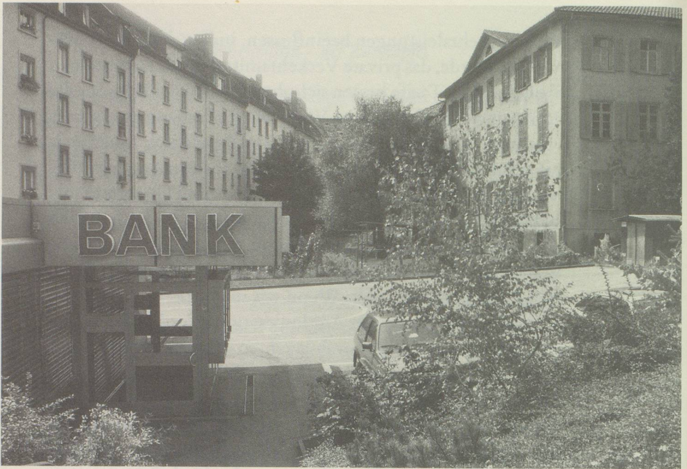
Klaffende Baulücke mit abbruchreifer oder renovationsbedürftiger Bausubstanz, das bei der Post Langgasse gelegene Baugelände mit der Geschäftsstelle der Kantonalbank und dem alten Textilgebäude...
