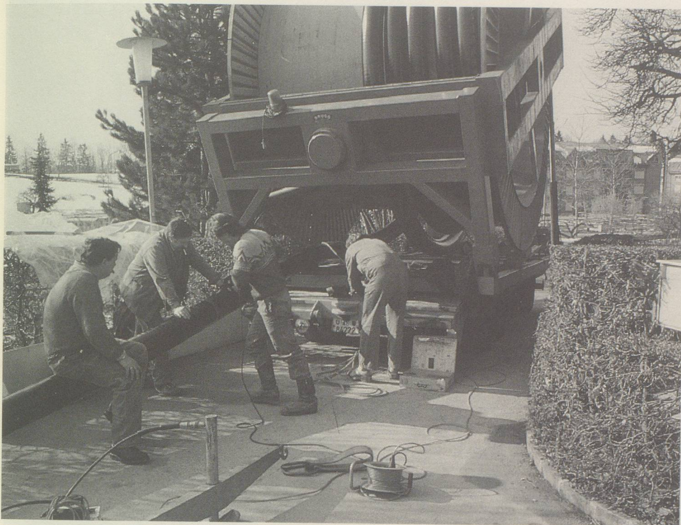
Montage eines flexiblen Rohrleitungsstückes
