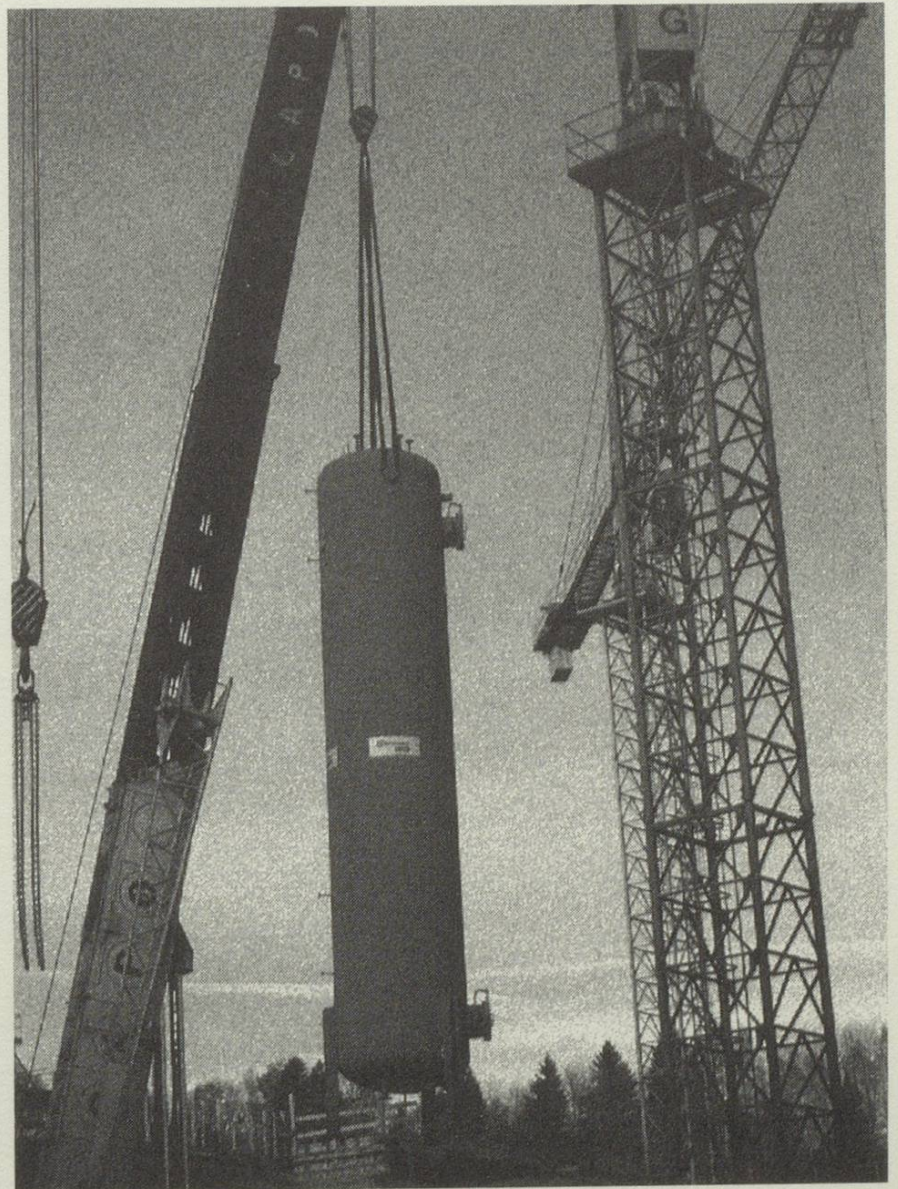
Versetzen eines Speichers mit 150m 3 Inhalt und 40 Tonnen Gewicht im Dezember 1985
