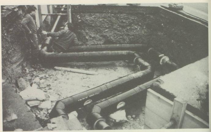
Montage eines mehrfachen Rohrbogens zur Aufnahme der Rohrdehnung beim Verbundmantelrohr-System
