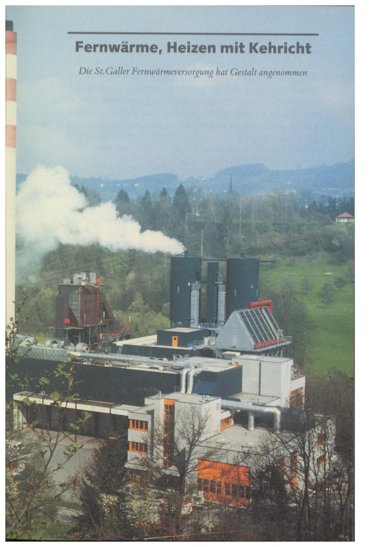
Eine Fernwärmeversorgung funktioniert grundsätzlich nicht anders als eine grosse Zentralheizung. Doch statt in jedem Haus einzeln wird für einen ganzen Stadtteil an einem Ort Wärme erzeugt. Die Fernwärme wird – wie Trinkwasser, Gas und Elektrizität – den Verbrauchern über ein gut isoliertes Verteilnetz in Form von heissem Wasser zugeleitet. Das in den Heizungen abgekühlte Wasser fliesst über ein zweites Rohr in die Fernwärmezentrale zurück, womit der Kreislauf geschlossen ist.
