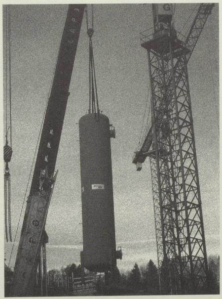
Versetzen eines Speichers mit 150m³ Inhalt und 40 Tonnen Gewicht im Dezember 1985
