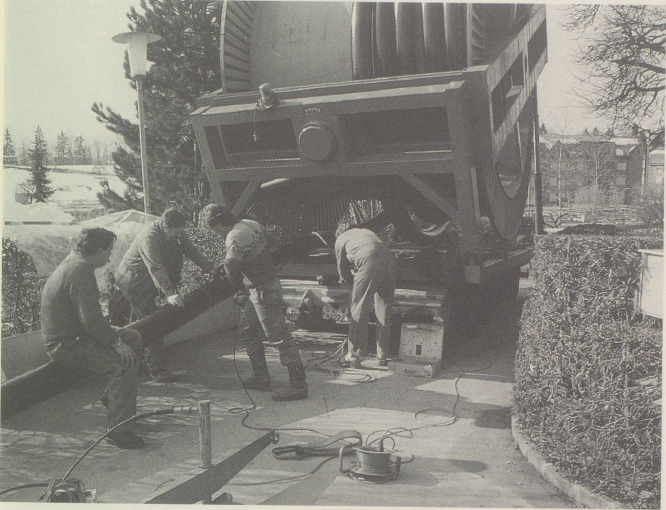
Montage eines flexiblen Rohrleitungsstückes
