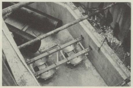
Fernwärme-Leitung mit Befestigungs-Einrichtung im nicht begehbaren Betonkanal
