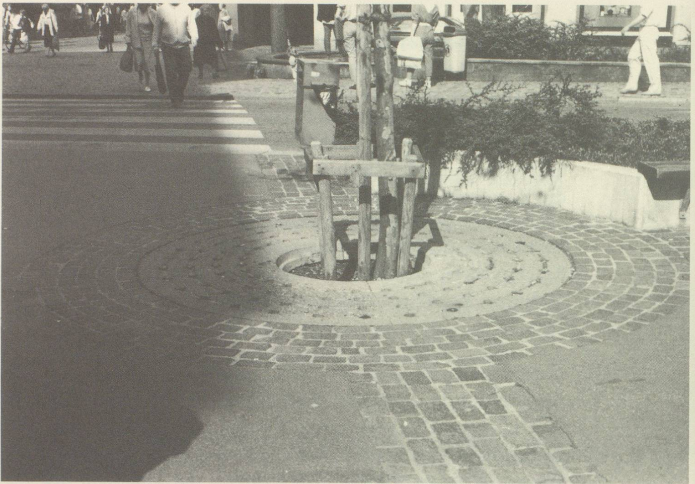
Den Wurzelbereich eines Baumes erleben wir als «Baumscheibe». In Wirklichkeit ist der Raumanspruch der Wurzeln demjenigen der Krone vergleichbar. Beispiel: Platane im Fussgängerbereich Vadianstrasse/Oberer Graben
