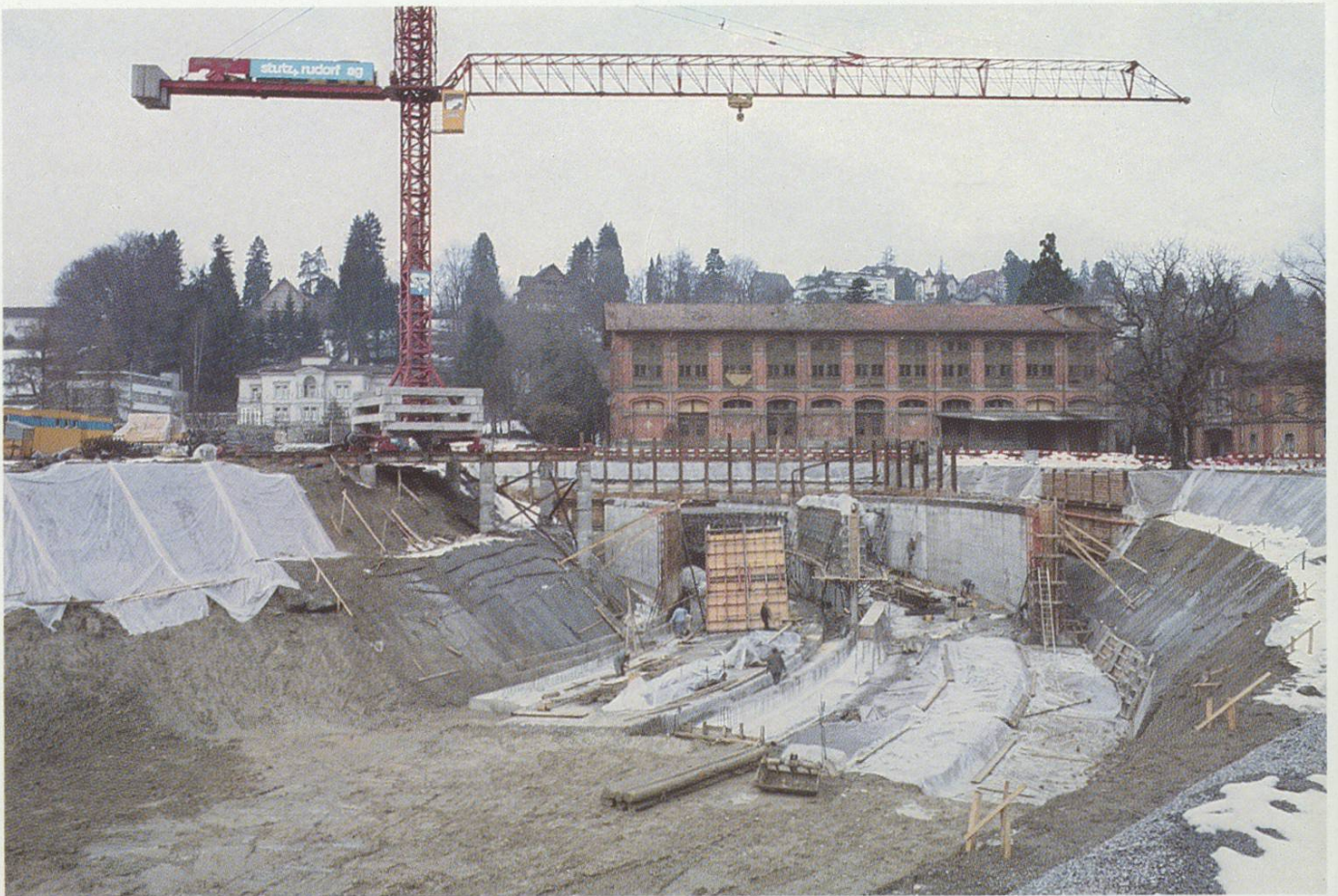
Längst wieder zugedeckt: Der zukünftige Tunnelzugang mit dem inzwischen abgebrochenen alten Zeughaus.
