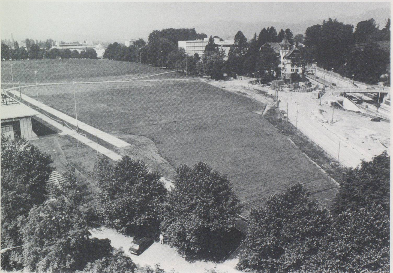
Die Kasernenwiese wird bald wieder Wiese sein. Von den Kasernenanlagen ist einzig die Offizierskantine stehengeblieben.
