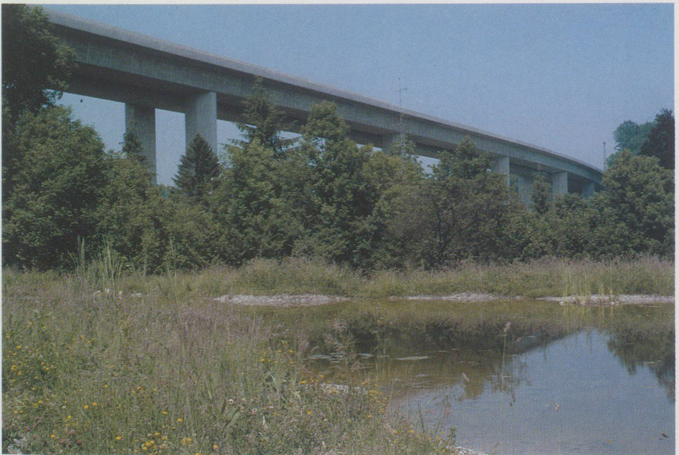
Mit Liebe angelegte Biotope mildern den Übergang von Autobahn zu Kulturland.
