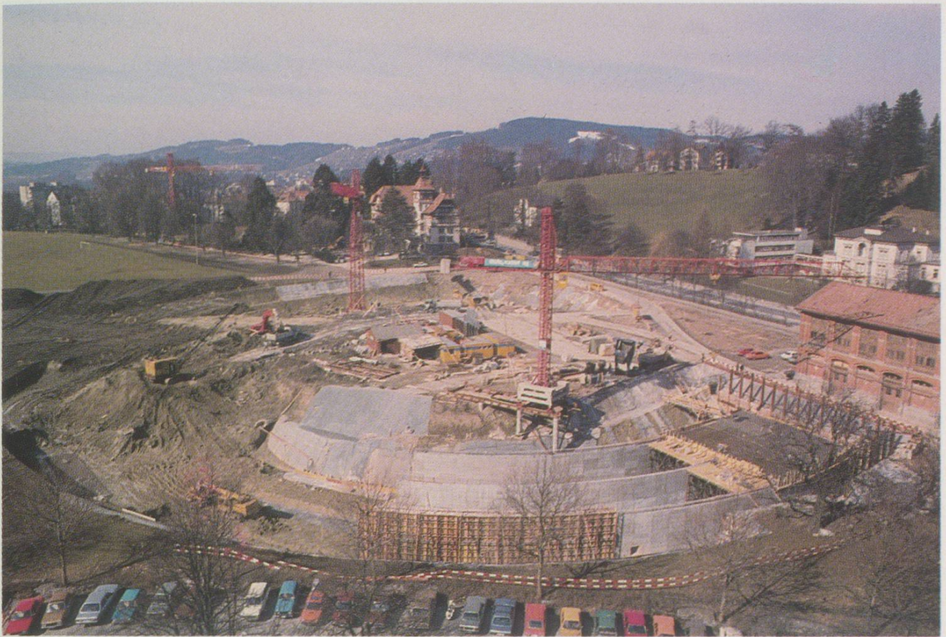
Im Tagbau wurden die Zufahrten an der Kasernenwiese erstellt.
