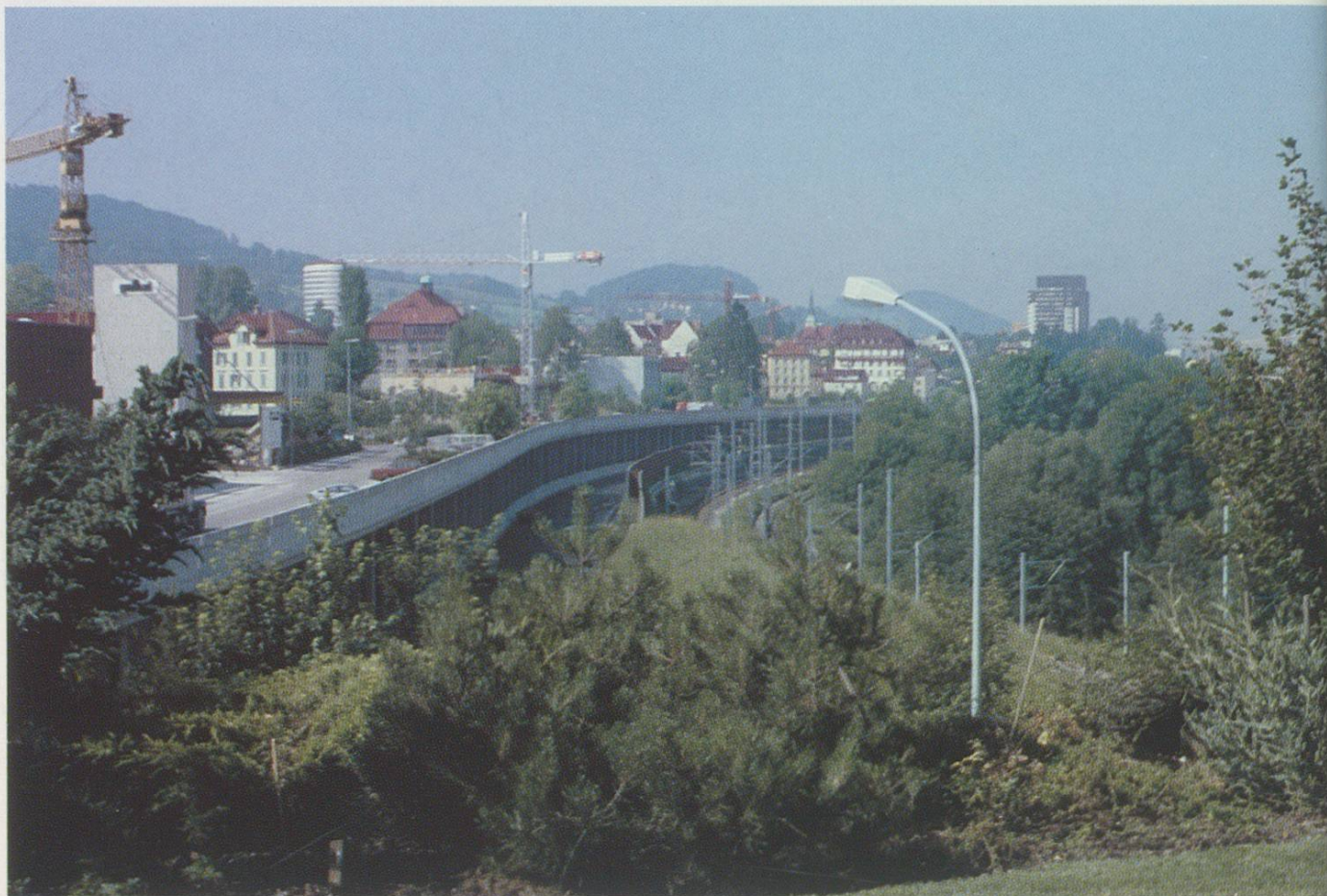
Beim Austritt aus dem Rosenbergtunnel ist die Autobahn mitten in städtischen Quartieren. Die beiden Farbbilder zeigen, wie gut die Autobahn dem Gelände angepasst worden ist. Auffallender die Überbrückungen.
