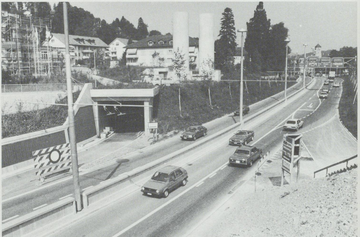
Im Blick die umstrittenen Lüftungskamine des Reitbahnanschlusses. Dank Neupflanzungen werden sie bald nicht mehr stark auffallen, doch die Bewohner des Rosenbergs hoffen, dass die Abgase gefiltert werden.
